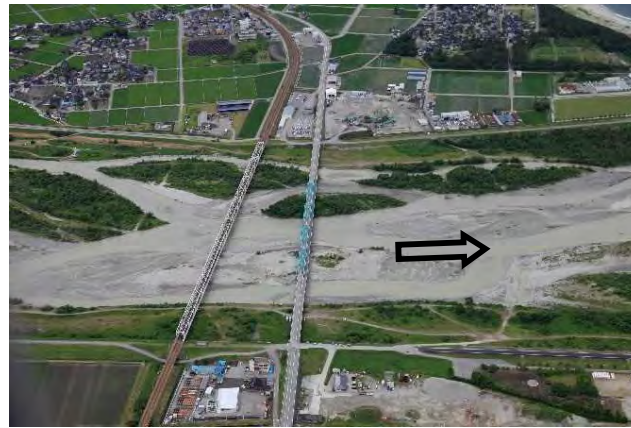
下黒部橋（河口より0.8km）
