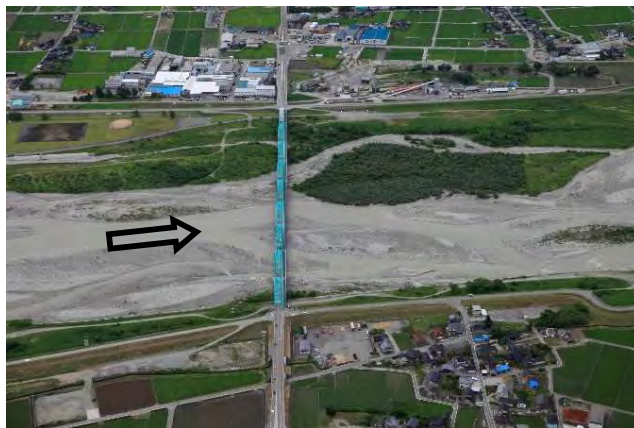
黒部大橋(国道8号)（河口より4.8km）
