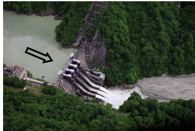
出し平ダム（右岸より望む）
