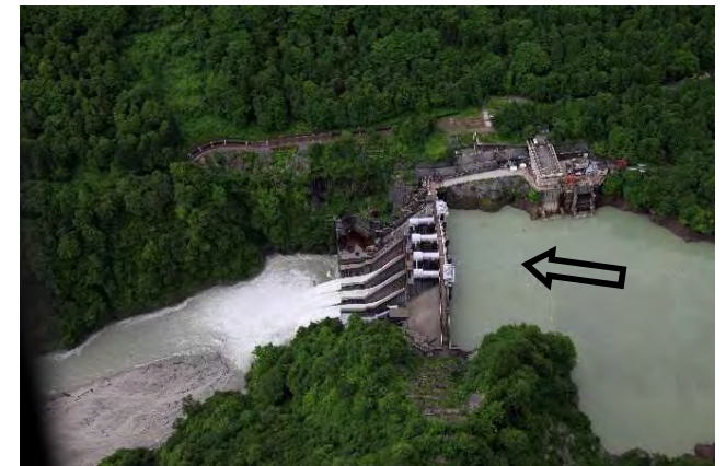
出し平ダム（左岸より望む）
