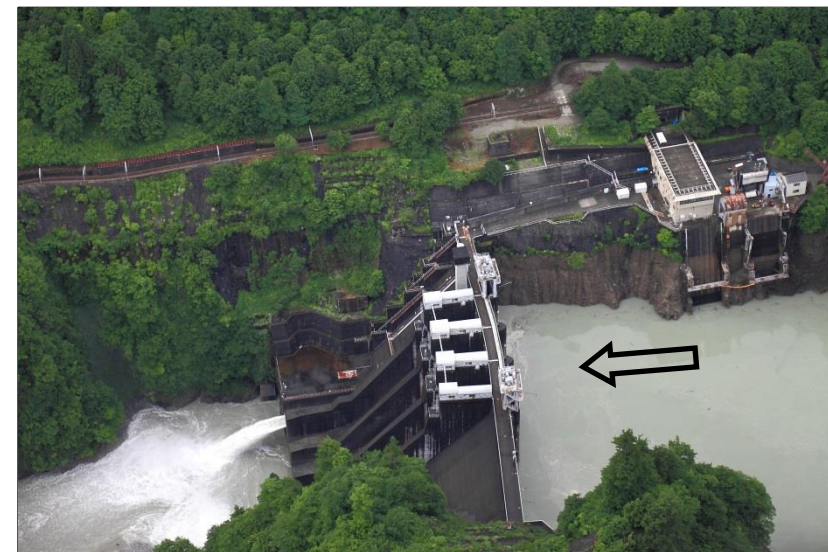
出し平ダム（左岸より望む）
