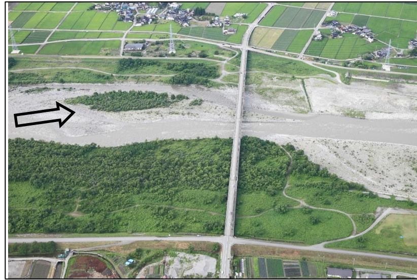
新川黒部橋（河口より9.6km）
