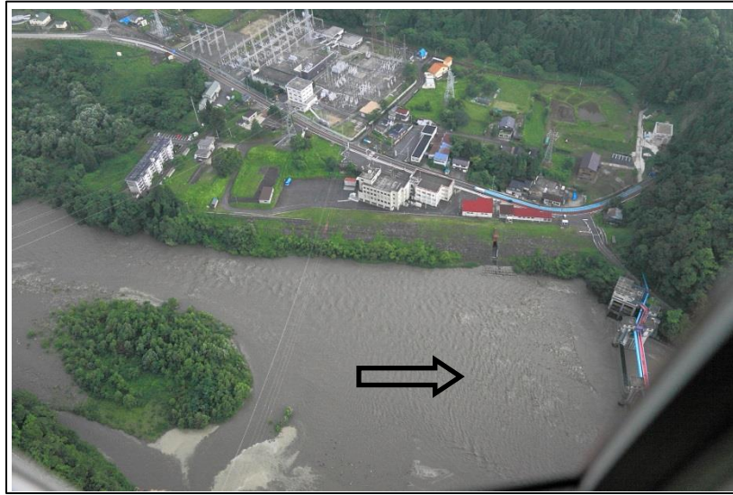
愛本合口堰堤（河口より13.5km） 6/25 15:51
