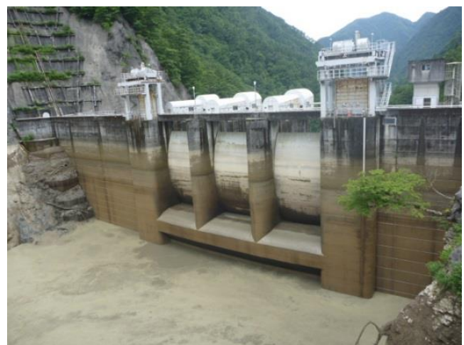
【出し平ダム排砂路呑み口部】 水位低下中 貯水位:EL315.73m 6月25日 11:20撮影
