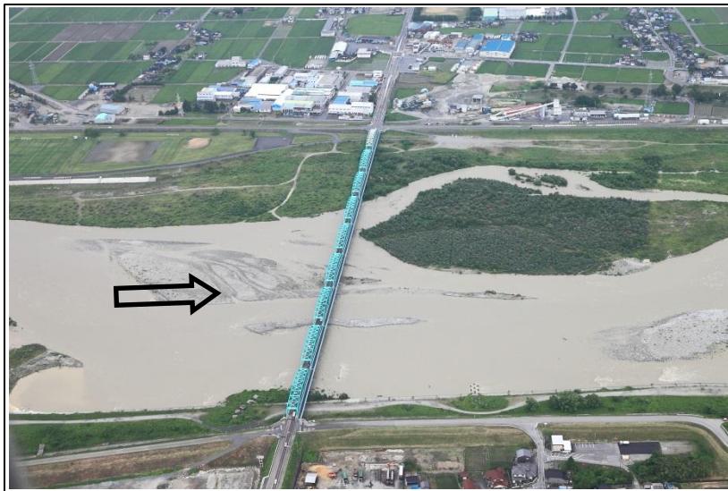
黒部大橋(国道8号)（河口より4.8km） 6/25 15:48
