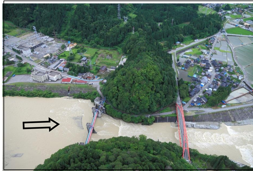
愛本合口堰堤（河口より13.5km）
