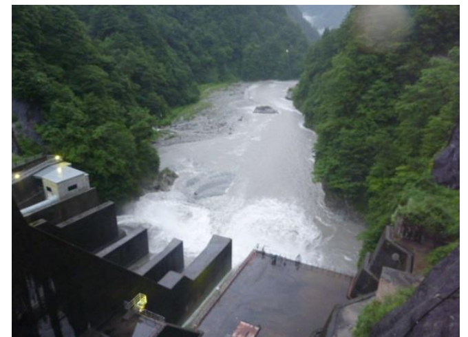
【出し平ダム下流】 自然流下完了 貯水位:EL308.69m 6月26日 5:00撮影
