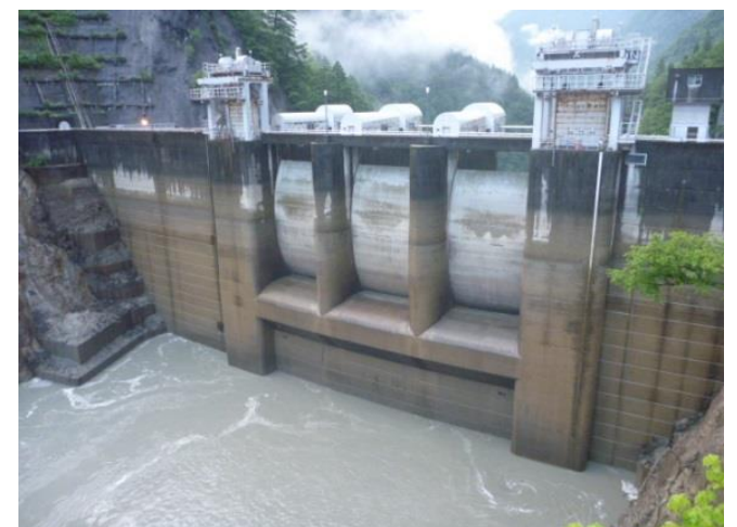
【出し平ダム排砂路呑み口部】 自然流下完了 貯水位:EL308.69m 6月26日 5:00撮影
