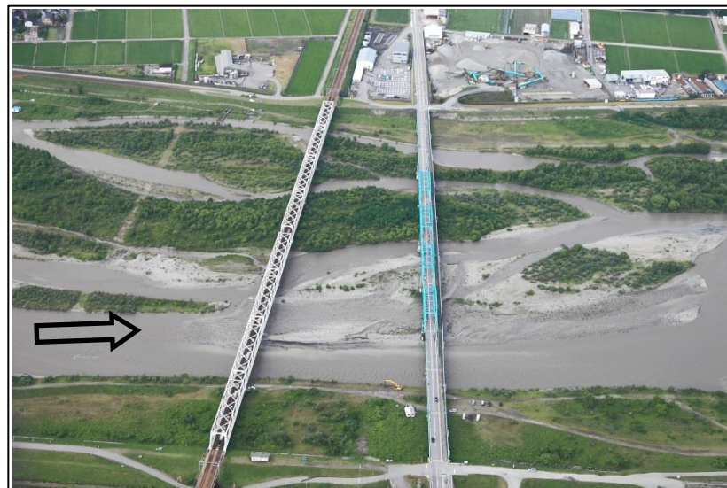
下黒部橋（河口より0.8km）
