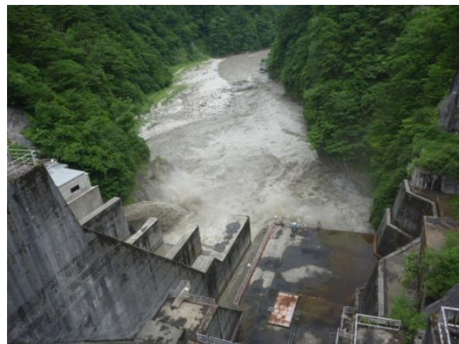
【出し平ダム下流】 水位低下中 貯水位:EL315.73m 6月25日 11:20撮影
