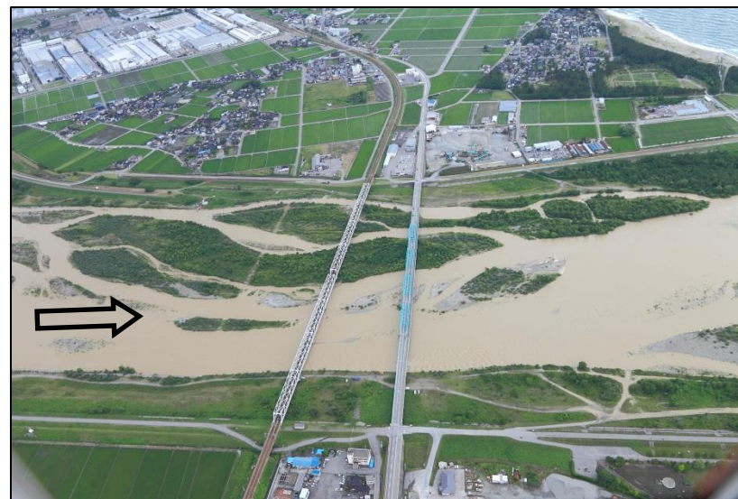
下黒部橋（河口より0.8km）
