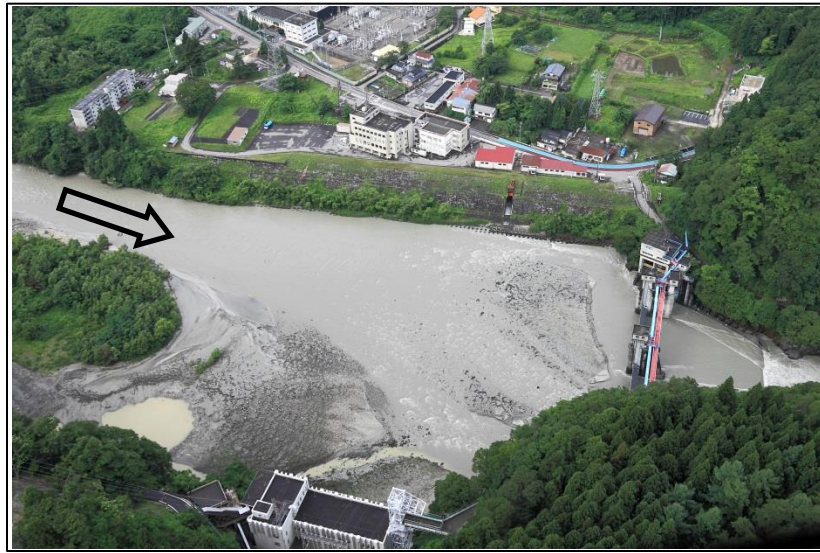
愛本合口堰堤（河口より13.5km）
