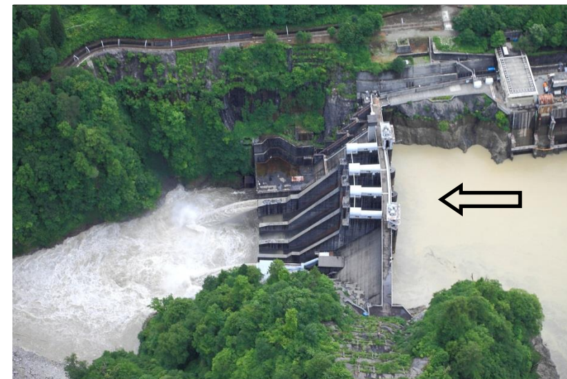
出し平ダム（左岸より望む）
