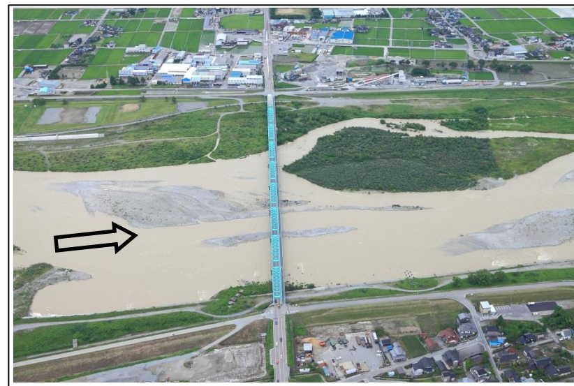
黒部大橋(国道8号)（河口より4.8km）
