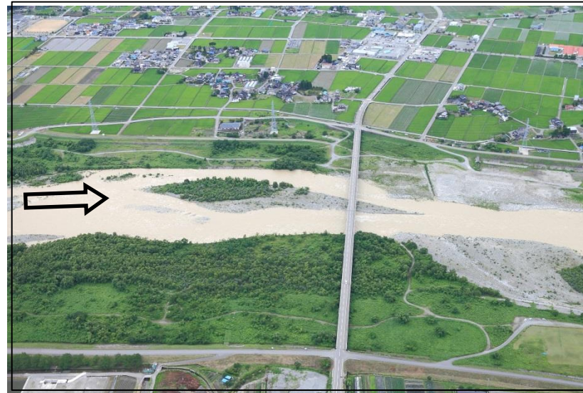
新川黒部橋（河口より9.6km）
