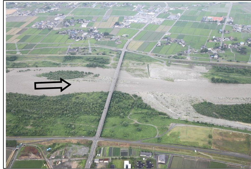
新川黒部橋（河口より9.6km） 6/25 15:49
