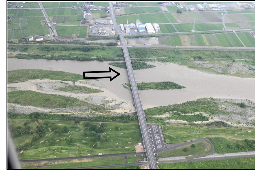
権蔵橋（河口より8.2km） 6/25 15:49
