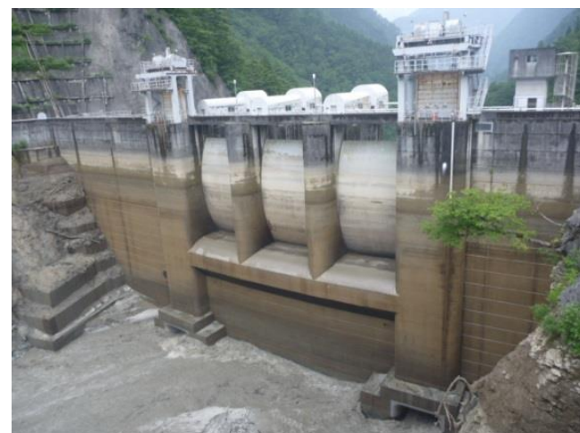
【出し平ダム排砂路呑み口部】 自然流下中 貯水位:EL305.88m 6月25日 16:00撮影
