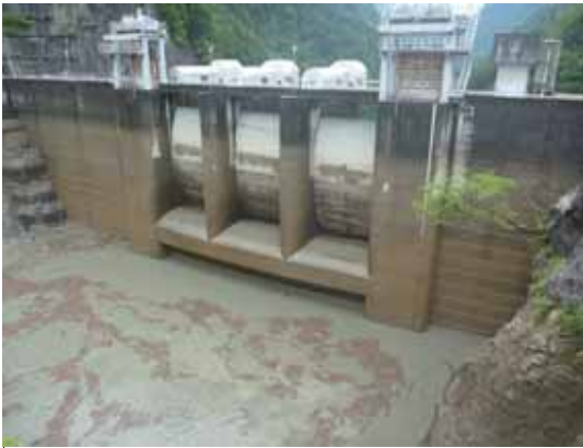
出し平ダム排砂路呑口部(12:25 水位低下中 貯水位:EL316.0m付近)
