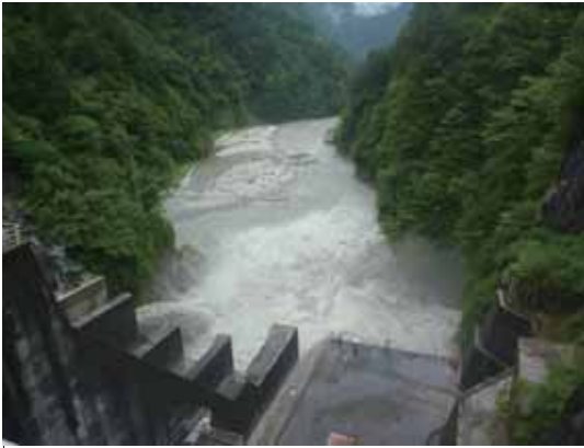
出し平ダム排砂路呑口部(12:25 水位低下中 貯水位:EL316.0m付近)
