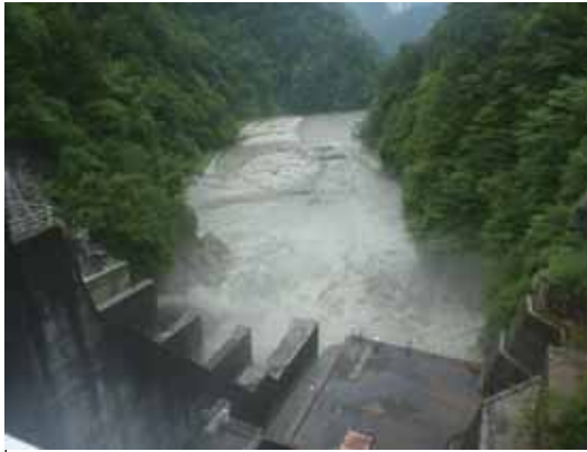
出し平ダム排砂路呑口部(13:15 水位低下中 貯水位:EL309.0mm付近)
