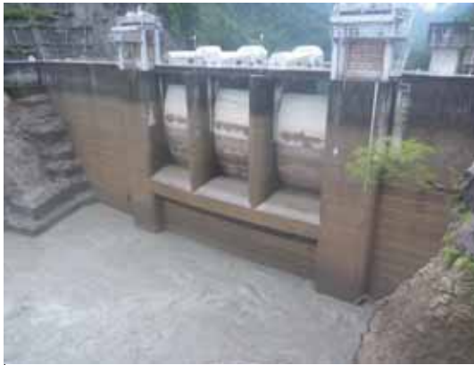
出し平ダム排砂路呑口部(13:15 水位低下中 貯水位:EL309.0mm付近)
