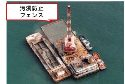
汚濁防止フェンス施工(例)
