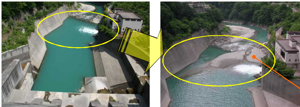
宇奈月ダム直下流の状況 (左：H24.5排砂前撮影 右：H24.6排砂後撮影)
