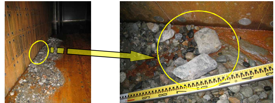
宇奈月ダム排砂路内に残っていた土砂 (H24排砂後撮影)
