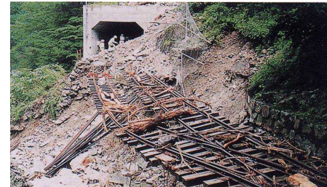
黒部峡谷鉄道被災状況
