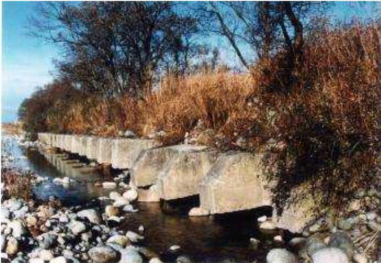
根固前面洗掘 沈下・浮き上がり状況
