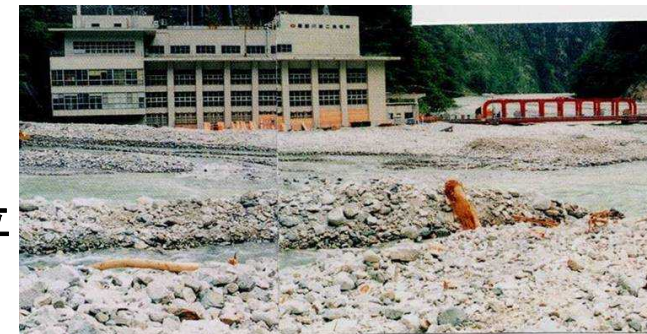
黒部川第2発電所付近被災状況
