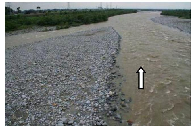
7月28日（出し平ダム：排砂ゲート開、宇奈月ダム：水位低下用ゲート開）
