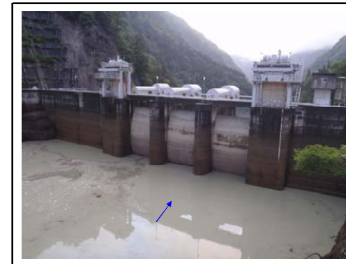
出し平ダム排砂路呑み口部(18:53 水位回復中 3.0m付近)
