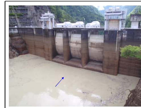
出し平ダム排砂路呑み口部(18:53 水位回復中 3.0m付近)
