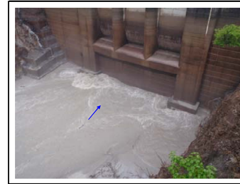
出し平ダム排砂路呑み口部(16:00 水位回復中 -4.0m付近)
