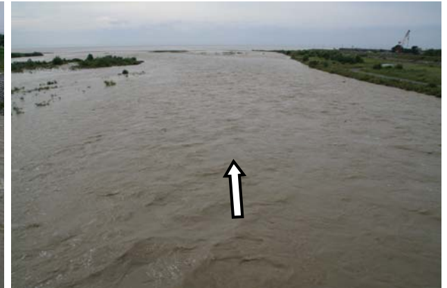
下黒部橋（河口より0.6km） 07/09 15:57
