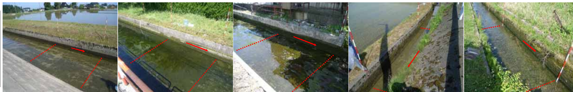
赤破線の5m区間が調査対象区間である。
