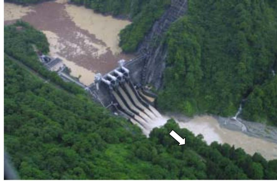
出し平ダム水位低下開始1時間経過、ダム流入量：394.7m<sup>3</sup>/s(15:00)
