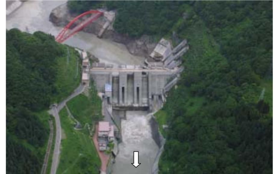
出し平ダム水位回復開始1時間30分経過 ダム流入量：188.2m<sup>3</sup>/s（15:00）
