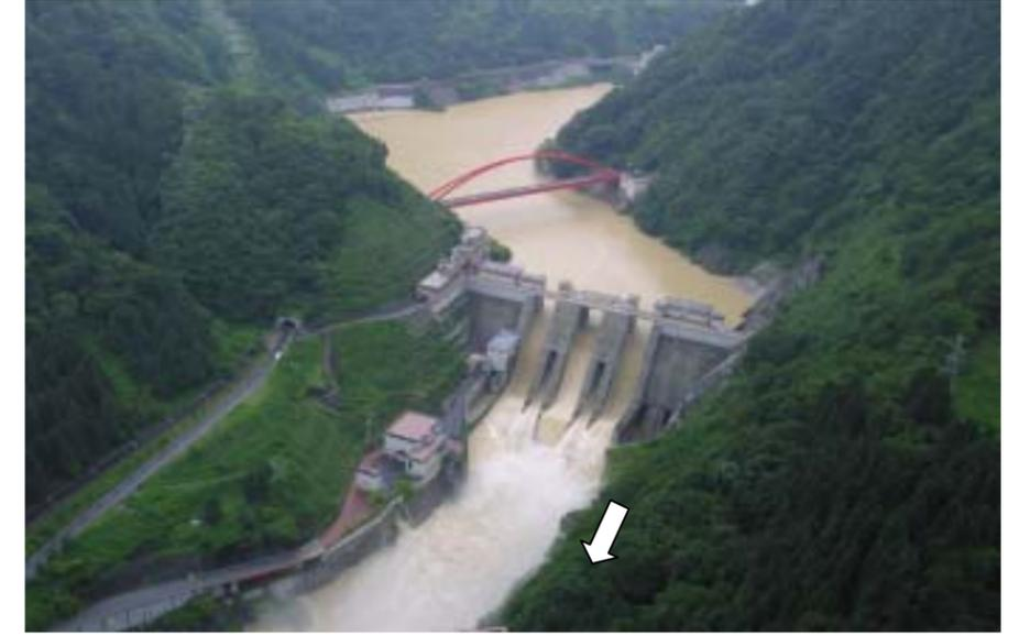
宇奈月ダム水位低下開始1時間経過、ダム流入量：515.8m<sup>3</sup>/s(15:00)
