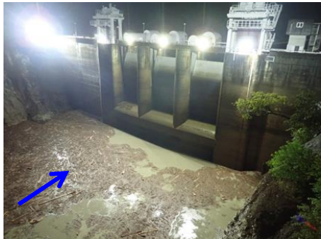
【出し平ダム排砂路呑口部】水位低下中 (EL. 315.97m) 8月28日 3:00撮影
