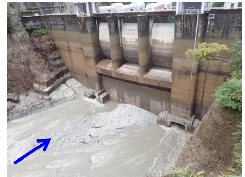
【出し平ダム排砂路呑口部】自然流下完了 (EL. 302.62m) 8月28日 13:10撮影
