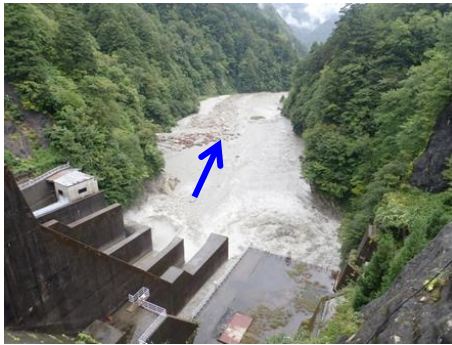
【出し平ダム下流】自然流下開始時 (EL. 305.44m) 8月28日 10:20撮影
