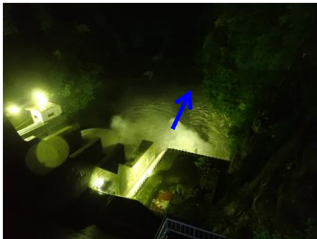
【出し平ダム下流】水位低下中 (EL. 315.97m) 8月28日 3:00撮影
