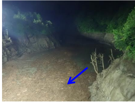
【出し平ダム湛水池】水位低下中 (EL. 315.97m) 8月28日 3:00撮影
