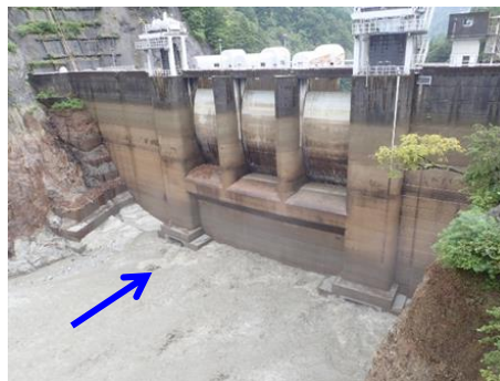
【出し平ダム排砂路呑口部】自然流下開始時 (EL. 305.44m) 8月28日 10:20撮影
