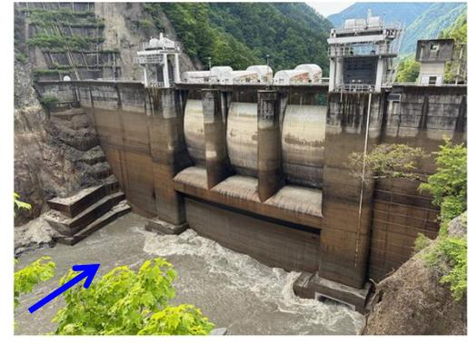
【出し平ダム排砂路呑口部】自然流下完了 (EL. 305.23m)
