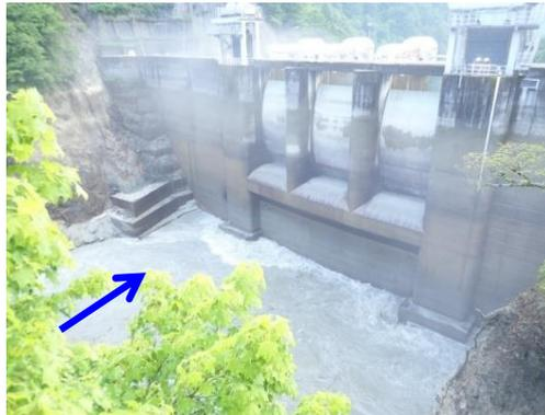
【出し平ダム排砂路呑口部】自然流下開始時 (EL. 306.73m)
