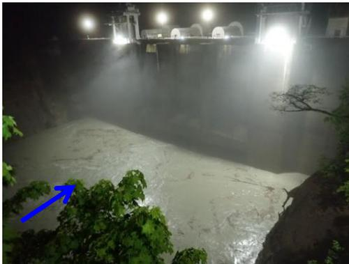
【出し平ダム排砂路呑口部】水位低下中 (EL. 315.90m)
