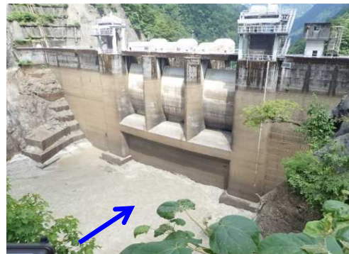
【出し平ダム排砂路呑口部】自然流下開始時 (EL. 305.99m) 7月31日 10:10撮影
