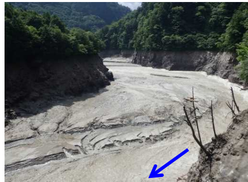
【出し平ダム湛水池】自然流下開始時 (EL. 305.99m) 7月31日 10:10撮影
