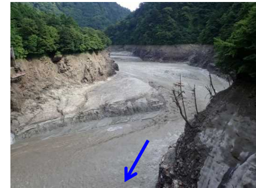
【出し平ダム湛水池】自然流下完了 (EL. 304.53m) 7月31日 15:05撮影
