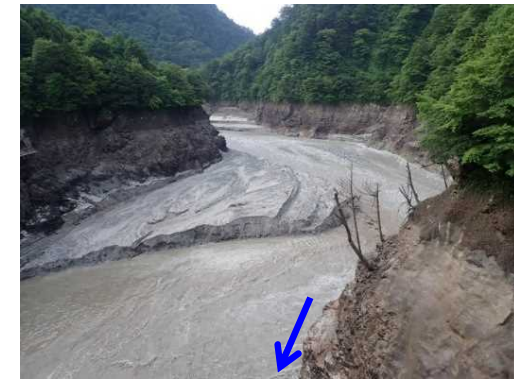
【出し平ダム湛水池】自然流下完了 (EL. 307.14m) 7月2日 6:45撮影
