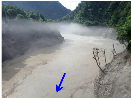
【出し平ダム湛水池】水位低下中 (EL. 315.50m) 7月31日 8:54撮影
