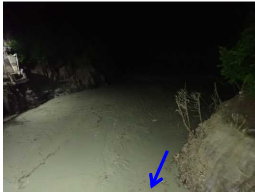
【出し平ダム湛水池】水位低下中 (EL. 315.88m) 7月1日 22:40撮影
