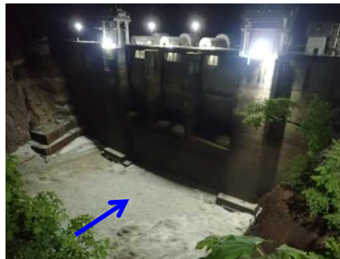
【出し平ダム排砂路呑口部】自然流下開始時 (EL. 306.24m) 7月2日 2:40撮影
