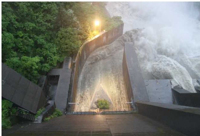
排砂ゲート開操作20分後 【6月24日5時10分】
