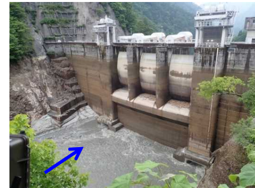
【出し平ダム排砂路呑口部】自然流下完了 (EL. 304. 30m) 6月24日 16:45撮影
