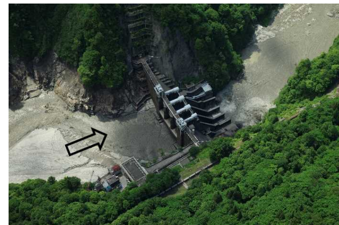
出し平ダム(右岸より望む)
