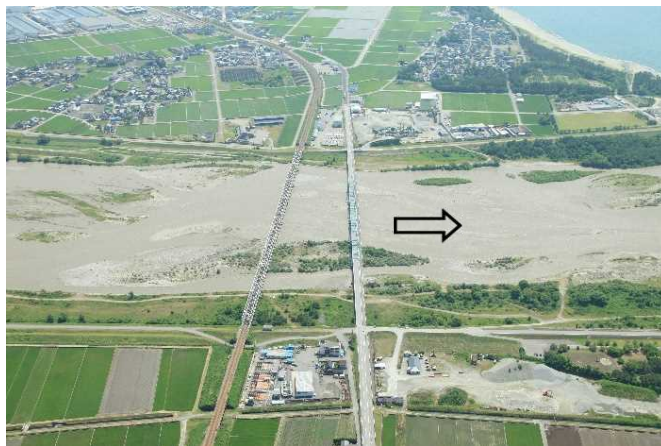
下黒部橋(河口より0.8km)
