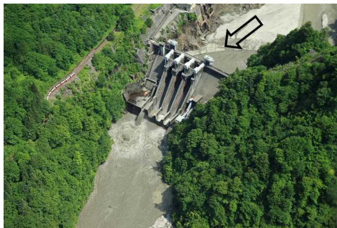
出し平ダム(左岸より望む)
