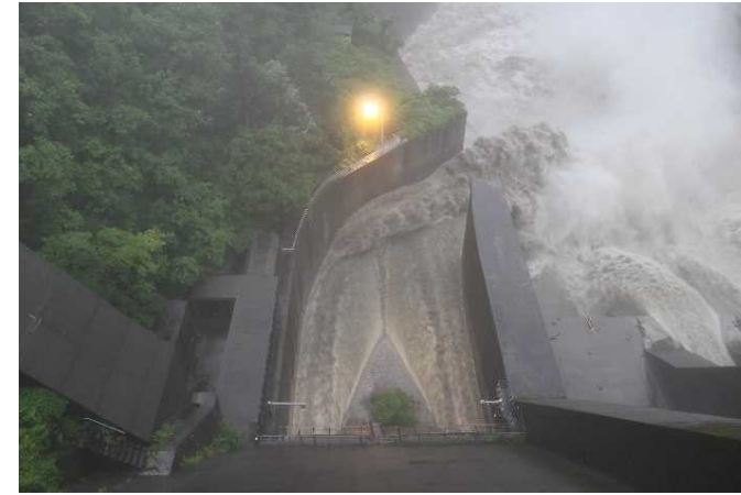
排砂ゲート開操作1時間後 【6月24日5時50分】
