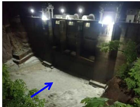
【出し平ダム排砂路呑口部】自然流下開始時 (EL. 306.24m)
