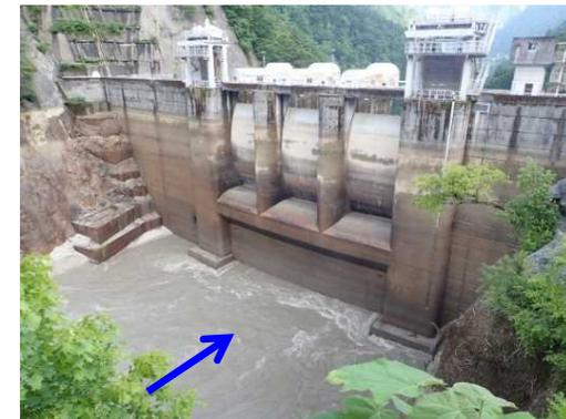
【出し平ダム排砂路呑口部】自然流下完了 (EL. 307.14m)
