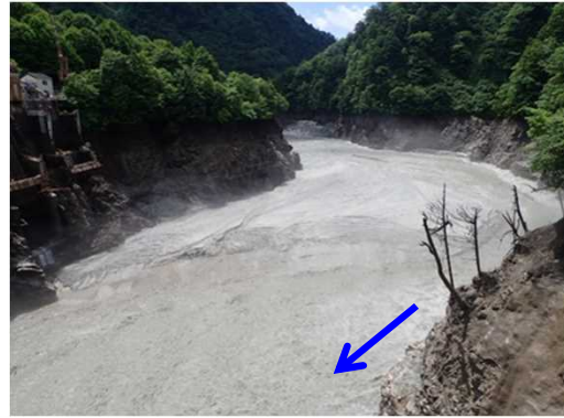
【出し平ダム湛水池】自然流下開始時 (EL. 306. 11m) 6月24日 10:30撮影
