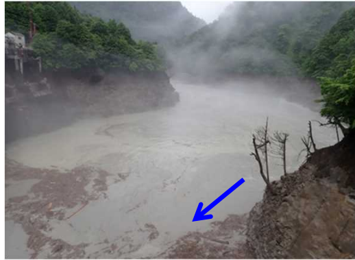
【出し平ダム湛水池】水位低下中 (EL. 316. 11m) 6月24日 6:55撮影
