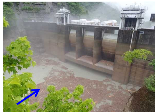
【出し平ダム排砂路呑口部】水位低下中 (EL. 316. 11m) 6月24日 6:55撮影
