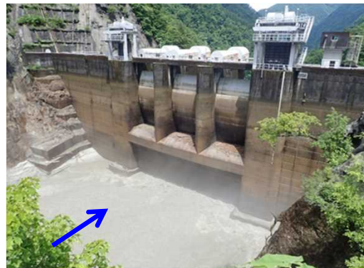
【出し平ダム排砂路呑口部】自然流下開始時 (EL. 306. 11m) 6月24日 10:30撮影
