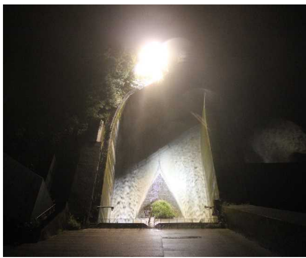
排砂ゲート開操作30分後 【7月5日20時00分】
