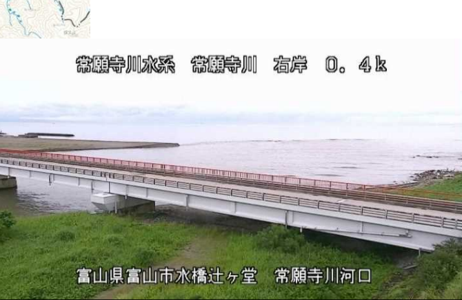
常願寺川 (7月6日 6:00 CCTV画像)
