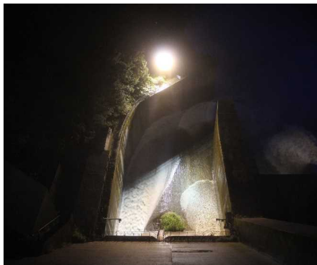
排砂ゲート開操作10分後 【7月5日19時40分】
