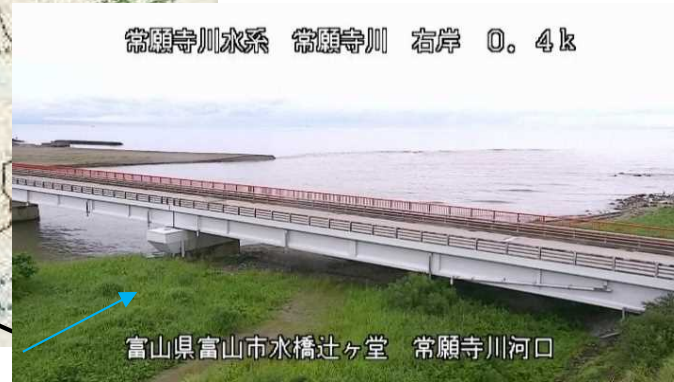
常願寺川 （7月6日 6：00 CCTV画像）
