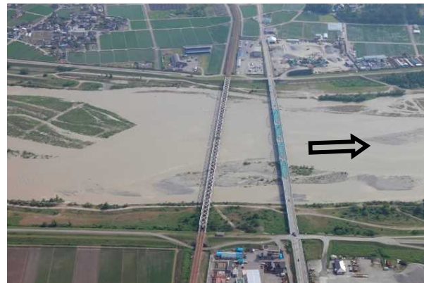
下黒部橋（河口より0.8km）
