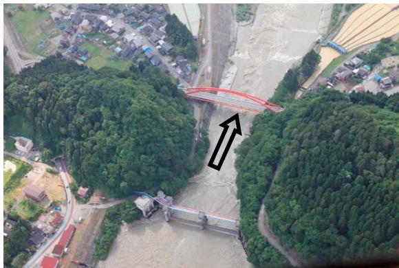
愛本合口堰堤（河口より13.5km）
