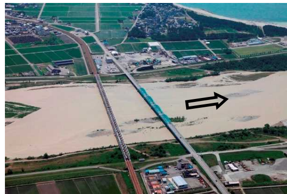
下黒部橋（河口より0.8km）
