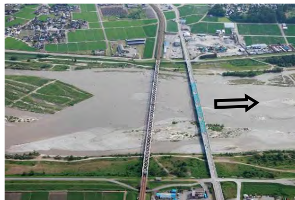
下黒部橋（河口より0.8km）
