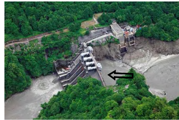
出し平ダム(左岸より望む)
