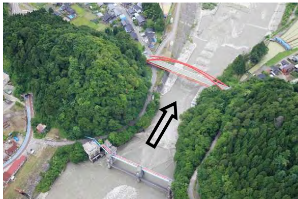
愛本合口堰堤（河口より13.5km）
