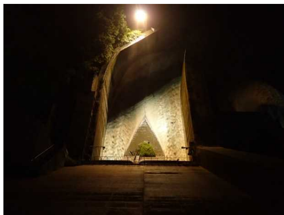
排砂ゲート開操作10分後 【6月26日22時10分】
