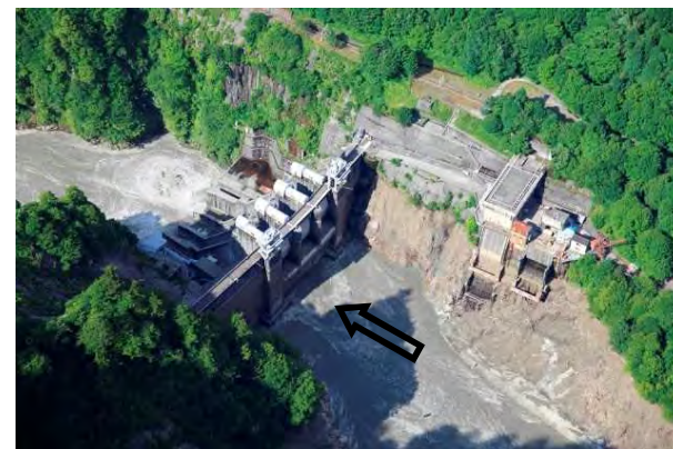
出し平ダム(左岸より望む)
