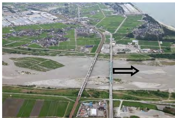
下黒部橋（河口より0.8km）
