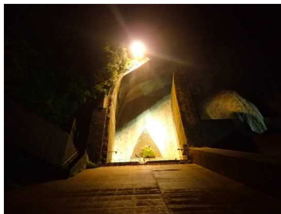
排砂ゲート開操作20分後 【6月26日22時20分】
