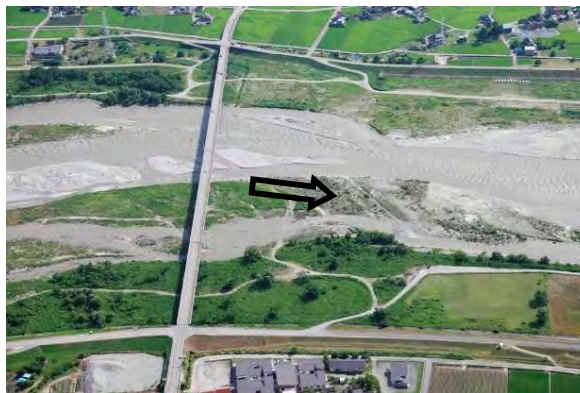
新川黒部橋（河口より9.6km）
