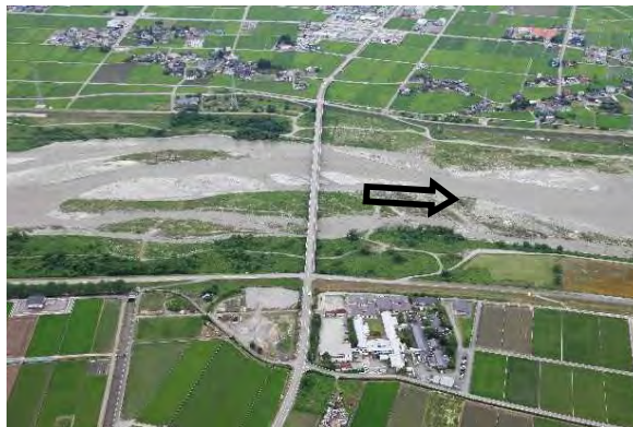
新川黒部橋（河口より9.6km）
