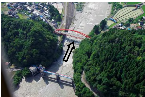
愛本合口堰堤（河口より13.5km）
