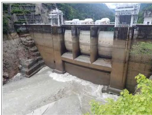
【出し平ダム排砂路呑口部】自然流下開始時(EL.305.16m)
