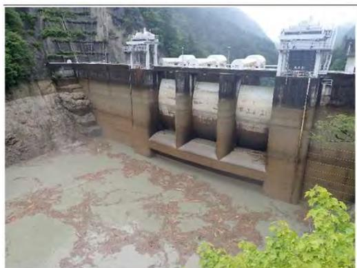
【出し平ダム排砂路呑口部】水位低下中(EL.316.00m)
