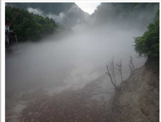
【出し平ダム湛水池】水位低下中(EL316.00m) 6月27日 5:00撮影
