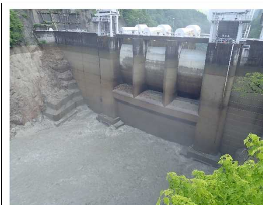
【出し平ダム排砂路呑口部】自然流下開始時(EL306.72m) 6月27日 6:34撮影
