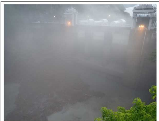
【出し平ダム排砂路呑口部】水位低下中(EL316.00m) 6月27日 5:00撮影
