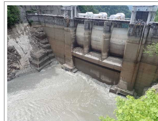
【出し平ダム排砂路呑口部】自然流下完了(EL303.92m) 6月27日 14:20撮影
