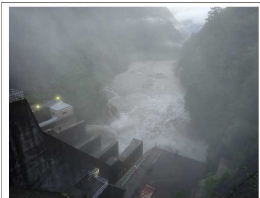
【出し平ダム下流】水位低下中(EL316.00m) 6月27日 5:00撮影
