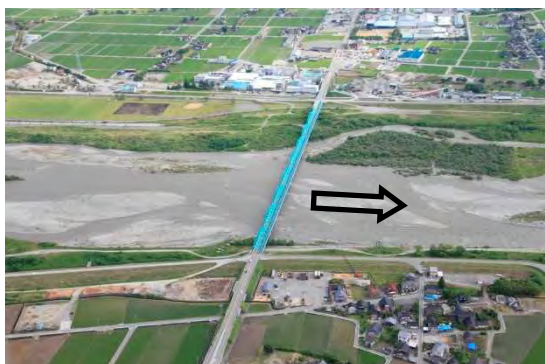
黒部大橋(国道8号)（河口より4.8km）
