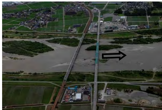
下黒部橋（河口より0.8km）
