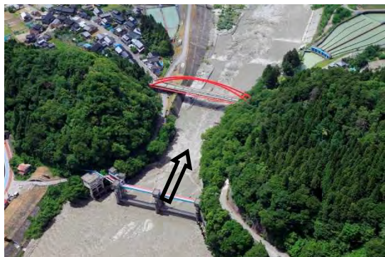
愛本合口堰堤（河口より13.5km）
