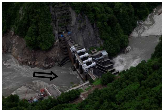
出し平ダム（右岸より望む）
