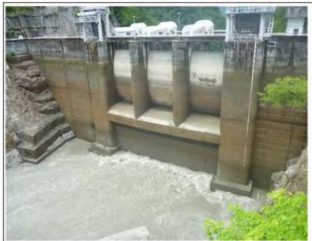
【出し平ダム排砂路呑み口部】自然流下中(EL.307.26m) 6月17日 12:45撮影
