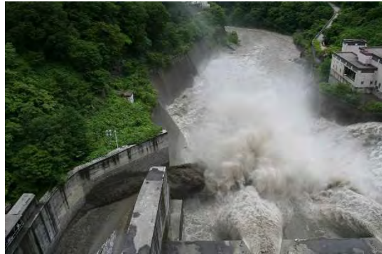
排砂G開操作10分後 【6月17日 10時10分】
