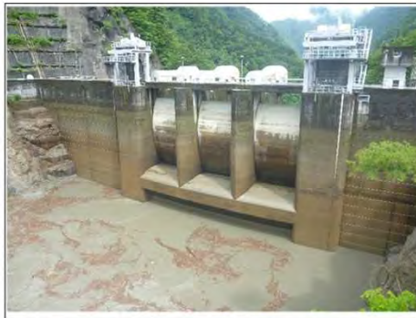
【出し平ダム排砂路呑み口部】水位低下中(EL.316.10m) 6月17日 9:20撮影
