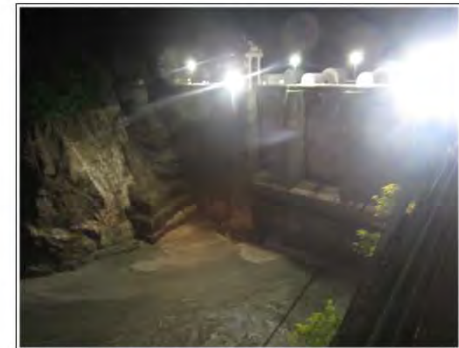
【出し平ダム排砂路呑み口部】自然流下完了(EL.305.23m) 6月17日 20:04撮影
