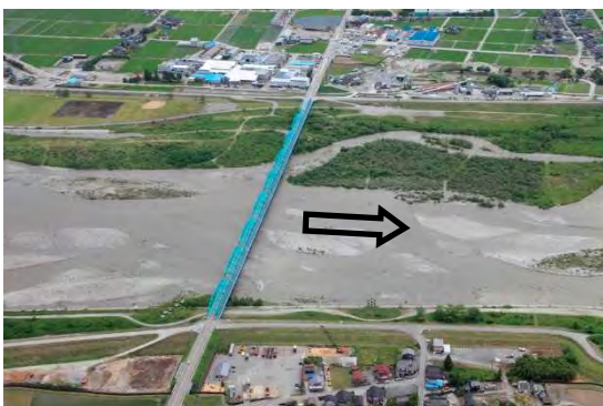
黒部大橋(国道8号)（河口より4.8km）
