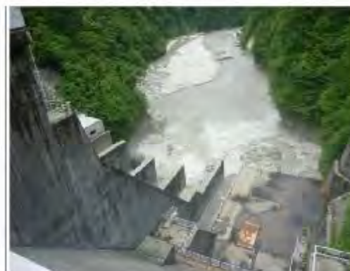
【出し平ダム下流】自然流下中(EL307.26m) 6月17日 12:45撮影
