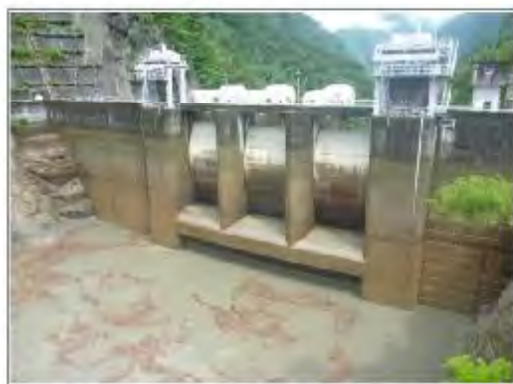
【出し平ダム排砂路呑み口部】水位低下中(EL316.10m) 6月17日 9:20撮影
