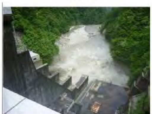
【出し平ダム下流】水位低下中(EL316.10m) 6月17日 9:20撮影
