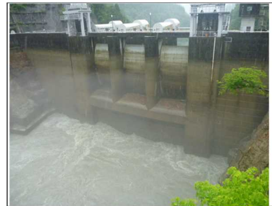
【出し平ダム排砂路呑み口部】自然流下完了(EL.308.80m) 7月7日 8:50撮影
