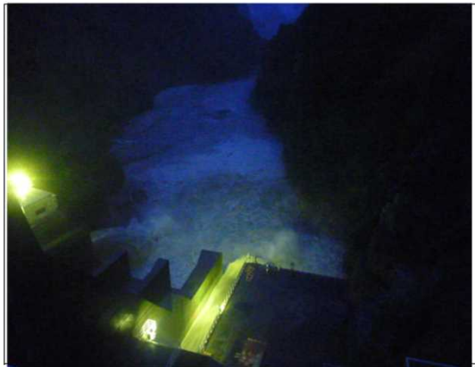
【出し平ダム下流】水位低下中(EL.315.77m) 7月6日 19:30撮影
