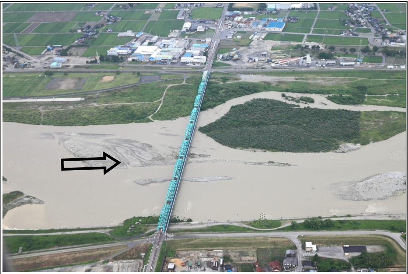
黒部大橋(国道8号)（河口より4.8km） 6/25 15:48
