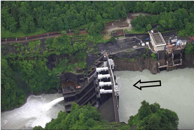
出し平ダム（左岸より望む）
