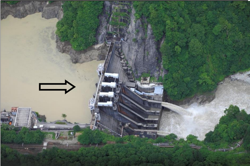
出し平ダム（右岸より望む）
