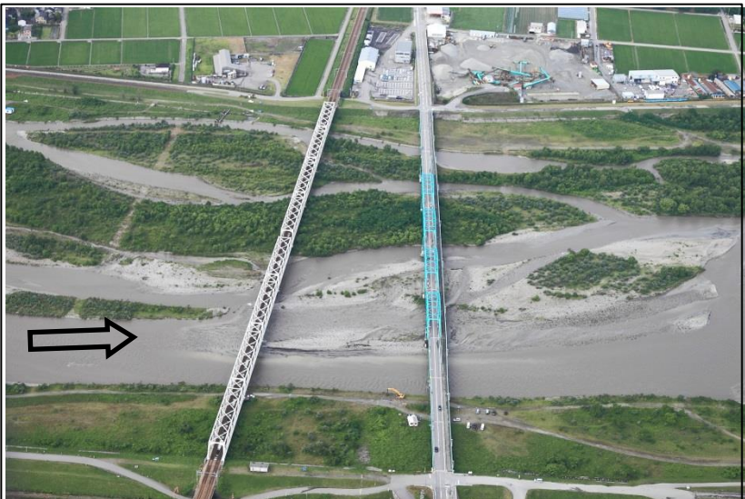
下黒部橋（河口より0.8km） 6/26 7:35
