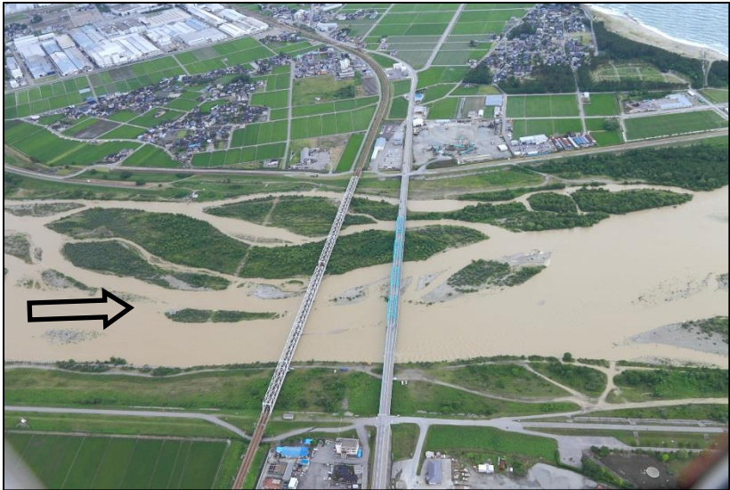
下黒部橋（河口より0.8km） 6/25 9:44
