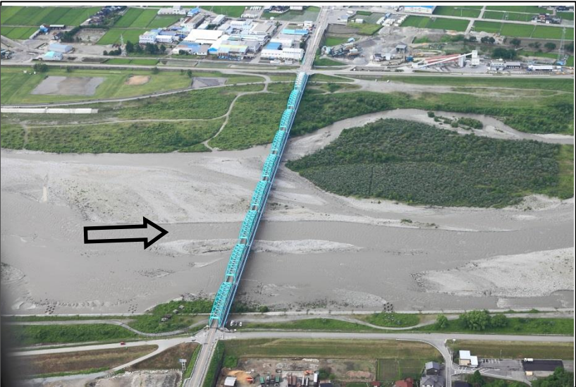
黒部大橋(国道8号)（河口より4.8km） 6/26 7:36
