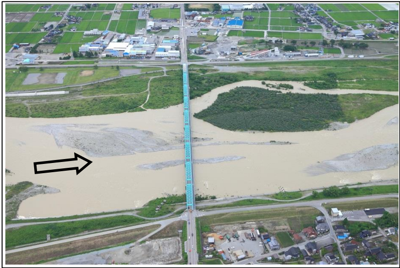
黒部大橋(国道8号)（河口より4.8km） 6/25 9:46
