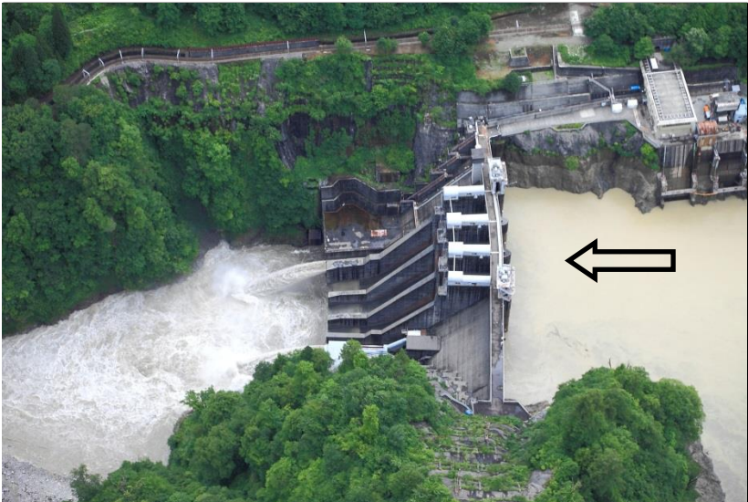
出し平ダム（左岸より望む）
