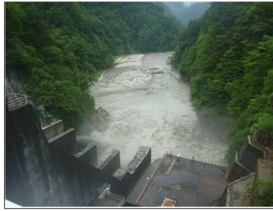
出し平ダム排砂路呑み口部(13:15 水位低下中 -16.0m付近)
