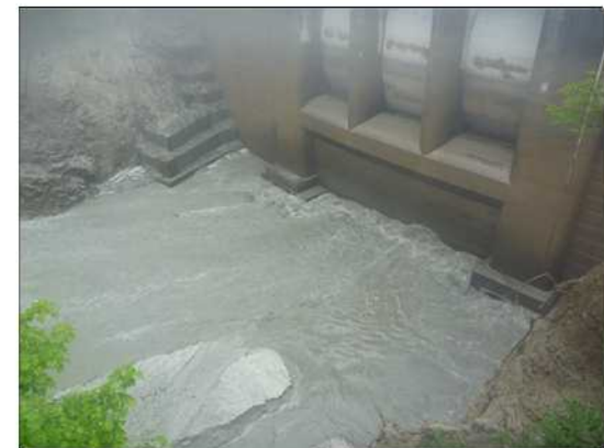
出し平ダム排砂路呑み口部(16:10 自然流下中)
