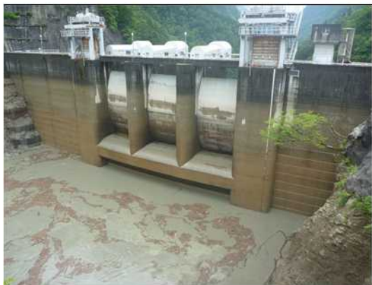
出し平ダム排砂路呑み口部(12:25 水位低下中 -9.0m付近)
