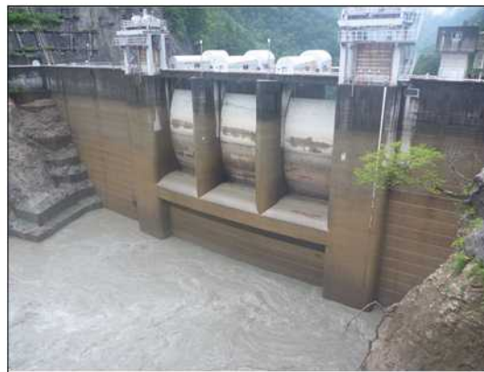
出し平ダム排砂路呑み口部(13:15 水位低下中 -16.0m付近)
