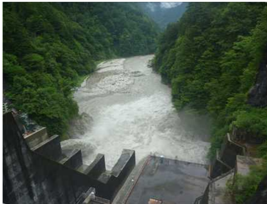
出し平ダム排砂路呑み口部(12:25 水位低下中 -9.0m付近)
