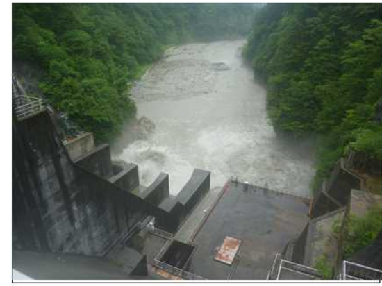
出し平ダム排砂路呑み口部(16:10 自然流下中)
