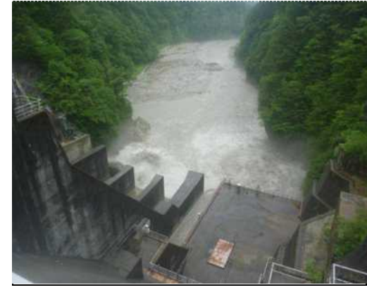
出し平ダム排砂路呑み口部(16:10 自然流下中)
