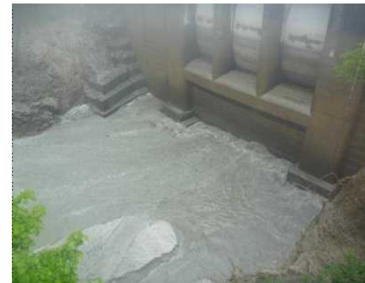
出し平ダム排砂路呑み口部(16:10 自然流下中)
