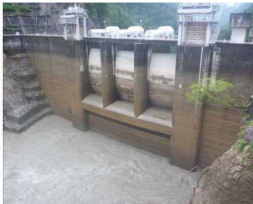
出し平ダム排砂路呑み口部(13:15 水位低下中 -16.0m付近)
