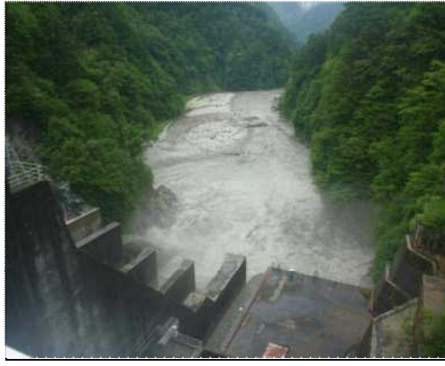
出し平ダム排砂路呑み口部(13:15 水位低下中 -16.0m付近)
