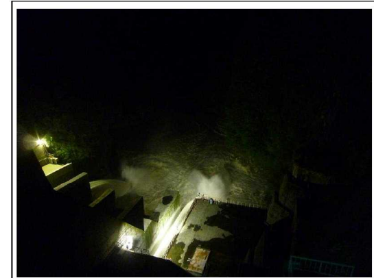
出し平ダム排砂路呑み口部(20時04分頃 水位回復中 -9.0m付近)
