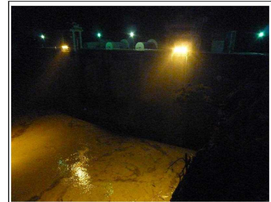
出し平ダム排砂路呑み口部(20時04分頃 水位回復中 -9.0m付近)
