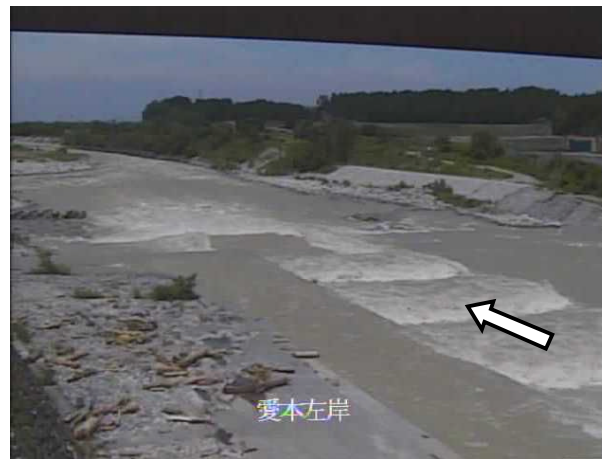
愛本橋下流（上流左岸より望む） 7/8 12:00
