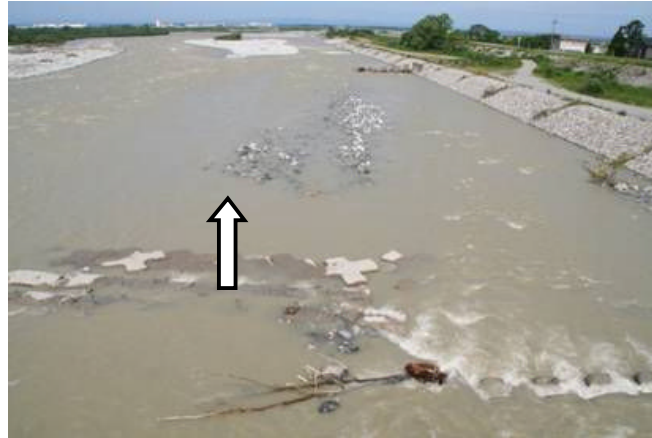
黒部大橋（国道8号）（河口より4.8km） 7/8 9:34
