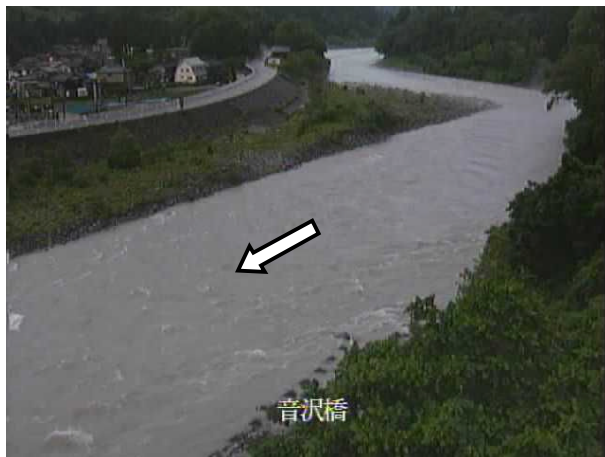
音沢橋（下流より望む） 6/29 5:00
