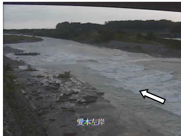
愛本橋下流（上流左岸より望む） 6/29 5:00
