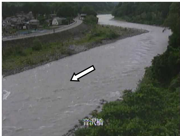
音沢橋（下流より望む） 6/28 10:00
