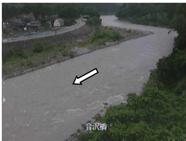
音沢橋（下流より望む） 6/28 15:00
