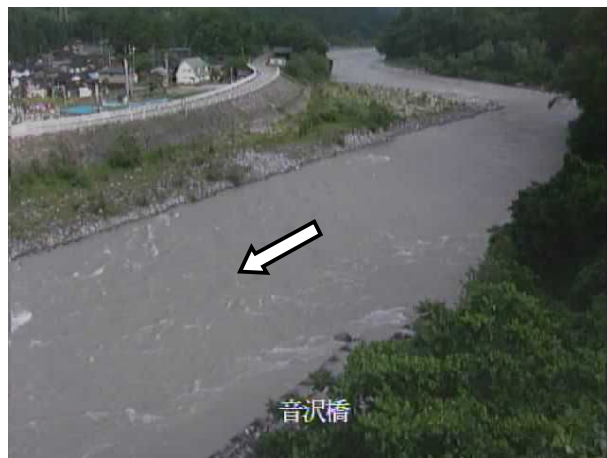
音沢橋（下流より望む） 6/29 16:00
