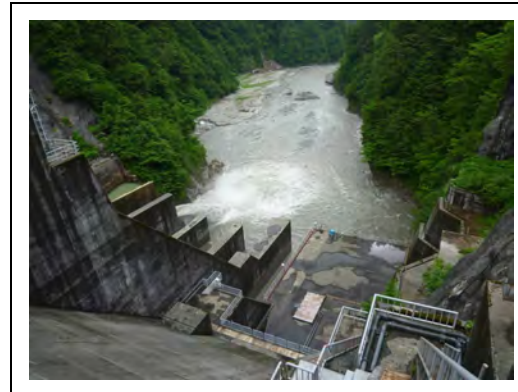
出し平ダム排砂路呑み口部(6/28 13:30頃 水位回復中 -9m付近)
