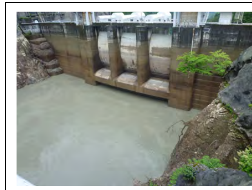
出し平ダム排砂路呑み口部(6/28 13:30頃 水位回復中 -9m付近)
