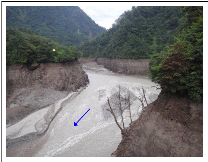
出し平ダム湛水池(6時頃 自然流下中)
