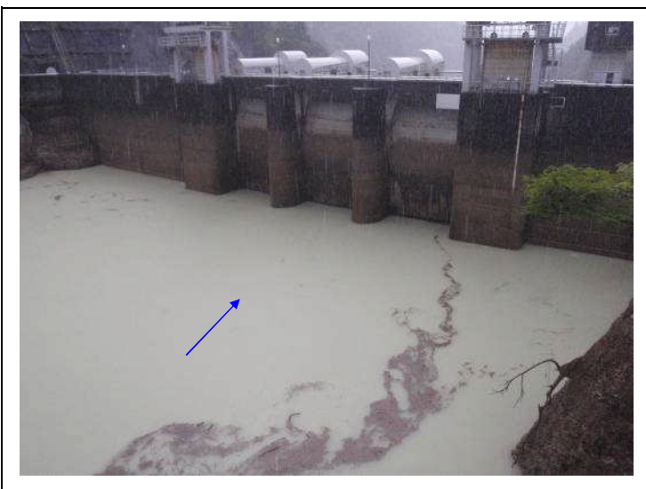
出し平ダム排砂路呑み口部(14時頃 水位回復中 3.0m付近)
