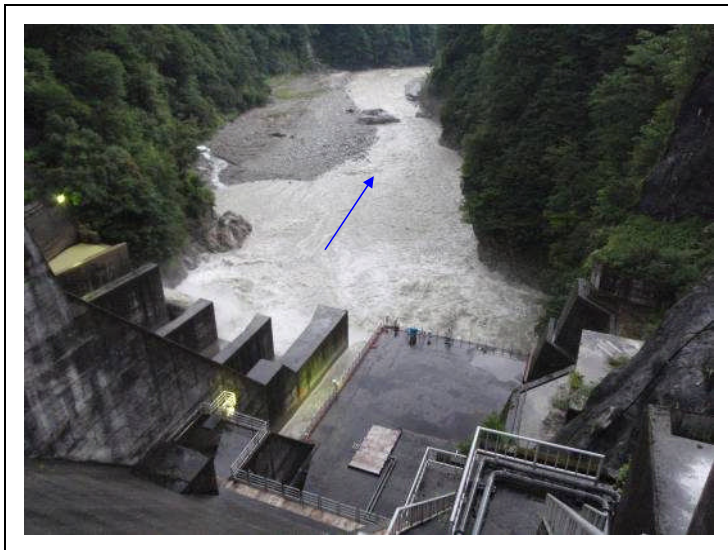
出し平ダム下流(6時頃 自然流下中)
