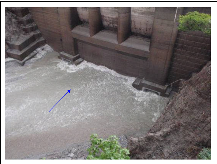
出し平ダム排砂路呑み口部(6時頃 自然流下中)
