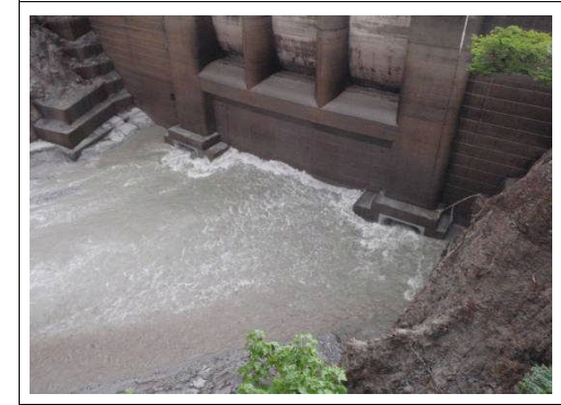
出し平ダム排砂路呑み口部11時頃 水位回復中 -4.0m付近)
