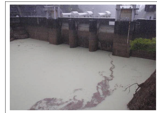
出し平ダム排砂路呑み口部11時頃 水位回復中 3.0m付近)
