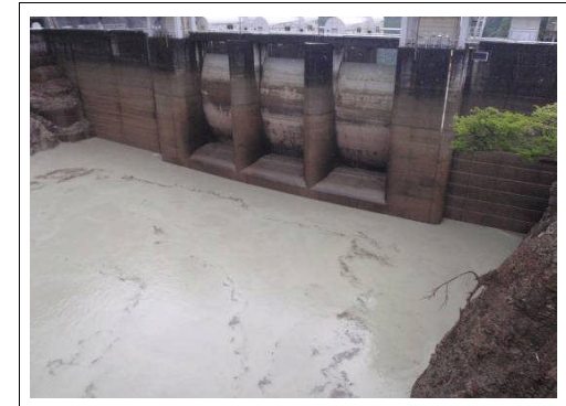
出し平ダム排砂路呑み口部11時頃 水位回復中 3.0m付近)
