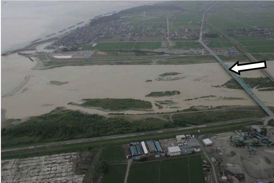
下黒部橋（河口より0.8km） 06/30 12:57
