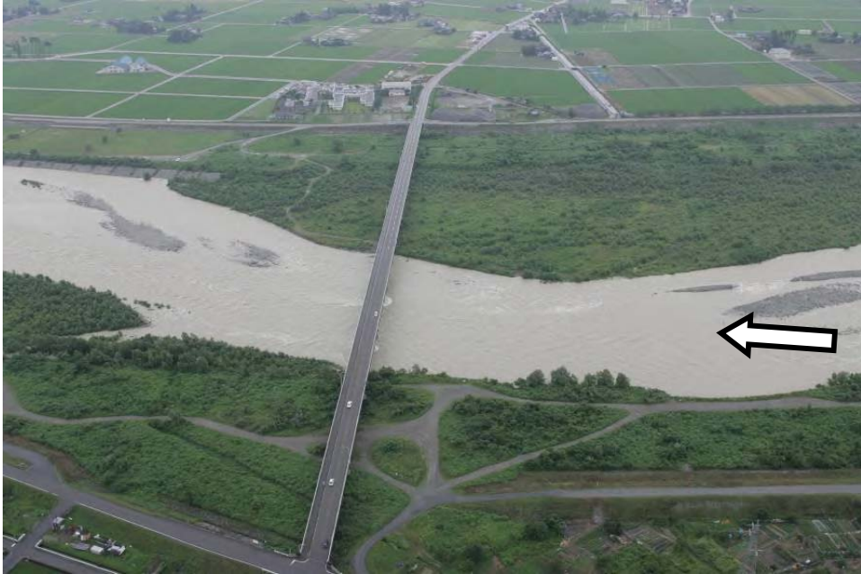
新川黒部橋（河口より9.6km） 06/30 12:53
