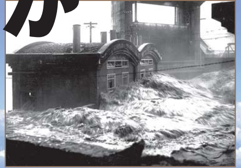
昭和27年7月洪水(愛本堰堤管理棟に流れ込む濁水)
