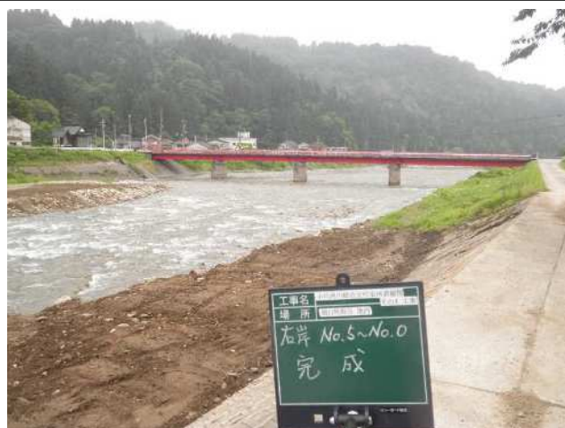
河道浚渫実施後(小川)
