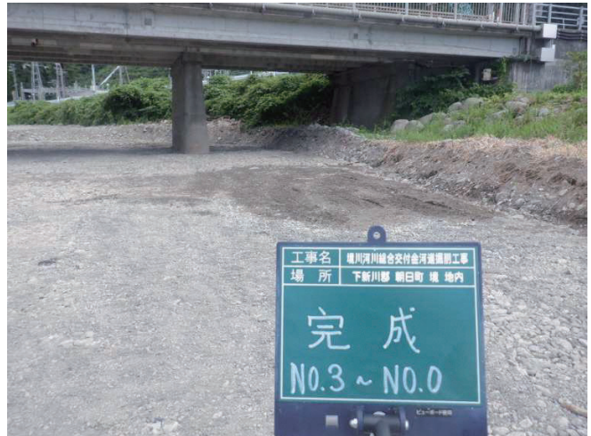
河道浚渫実施後(境川)
