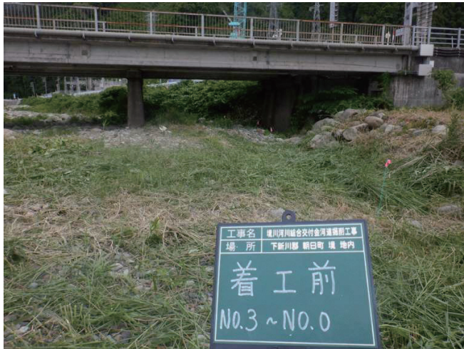
河道浚渫実施前(境川)
