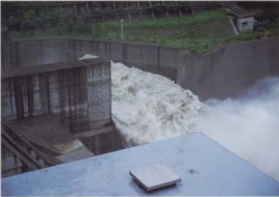
宇奈月ダム自然流下開始直後 H13. 6. 21、5:30撮影 放流量 363 m 3 /s
