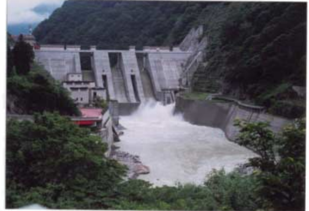
宇奈月ダム自然流下完了直前 H13. 6. 21、16:20撮影 放流量 172 m 3 /s
