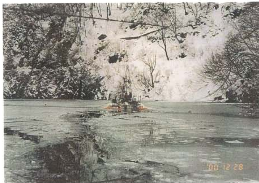
ボーリング作業状況(平成12年12月28日)
