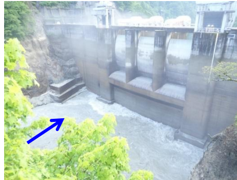
【出し平ダム排砂路呑口部】自然流下開始時 (EL. 306. 73m) 6月16日 6:30撮影
