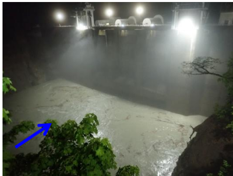
【出し平ダム排砂路呑口部】水位低下中 (EL. 315. 90m) 6月15日 20:30撮影
