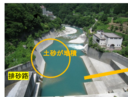
減勢池内に20cm内外の土砂が堆積（H27減勢池調査）
