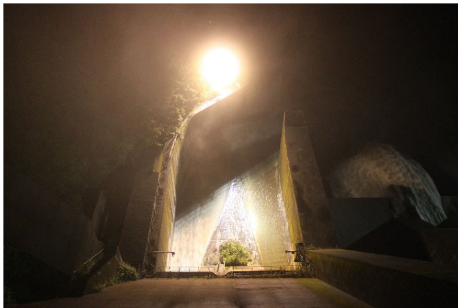
排砂ゲート開操作10分後 【7月31日3時50分】
