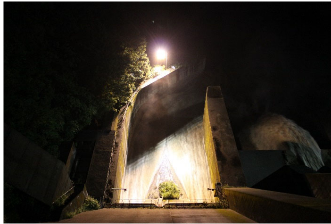
排砂ゲート開操作20分後 【7月31日4時10分】
