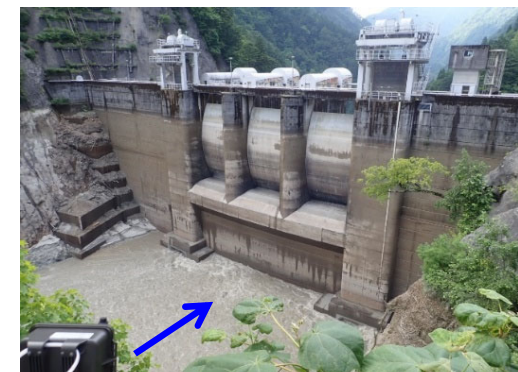
【出し平ダム排砂路呑口部】自然流下完了 (EL. 304.53m) 7月31日 15:05撮影
