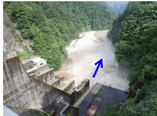
【出し平ダム下流】水位低下中 (EL. 315.50m) 7月31日 8:54撮影
