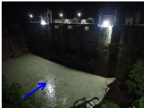
【出し平ダム排砂路呑口部】水位低下中 (EL. 315.88m) 7月1日 22:40撮影
