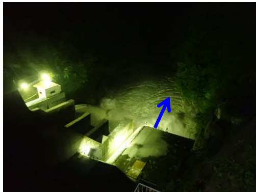
【出し平ダム下流】水位低下中 (EL. 315.88m) 7月1日 22:40撮影
