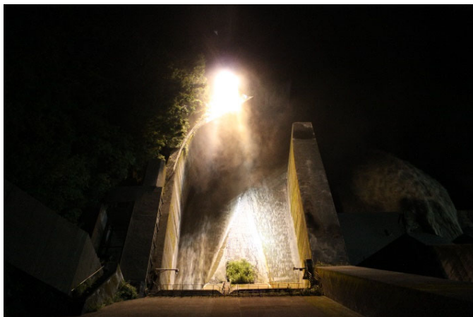
排砂ゲート開操作10分後 【7月1日21時00分】
