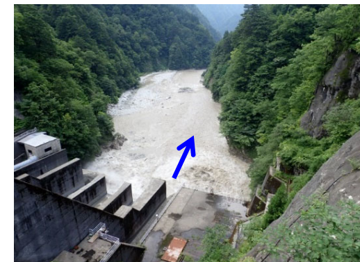
【出し平ダム下流】自然流下完了 (EL. 304.53m) 7月31日 15:05撮影
