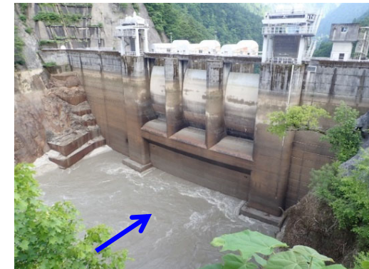
【出し平ダム排砂路呑口部】自然流下完了 (EL. 307.14m) 7月2日 6:45撮影
