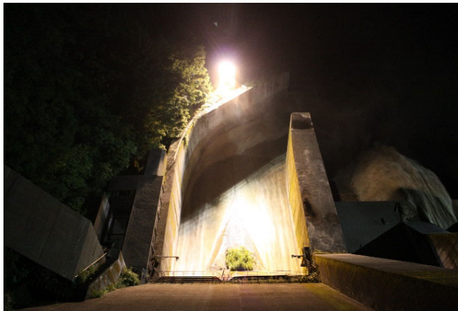
排砂ゲート開操作20分後 【7月1日21時20分】
