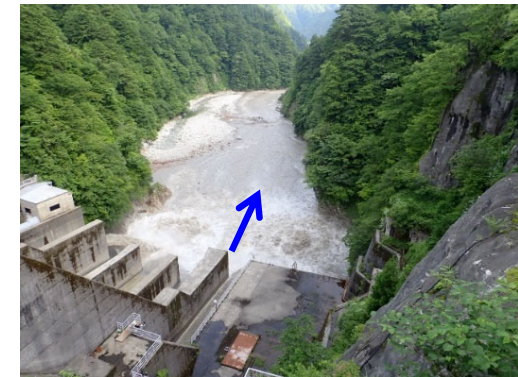
【出し平ダム下流】自然流下完了 (EL. 307.14m) 7月2日 6:45撮影
