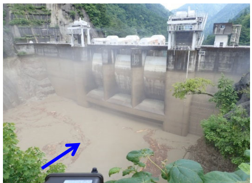
【出し平ダム排砂路呑口部】水位低下中 (EL. 315.50m) 7月31日 8:54撮影
