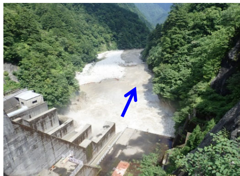
【出し平ダム下流】自然流下開始時 (EL. 305.99m) 7月31日 10:10撮影
