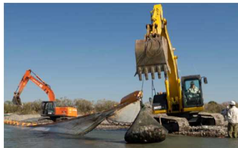
掘削前の防護膜の設置
