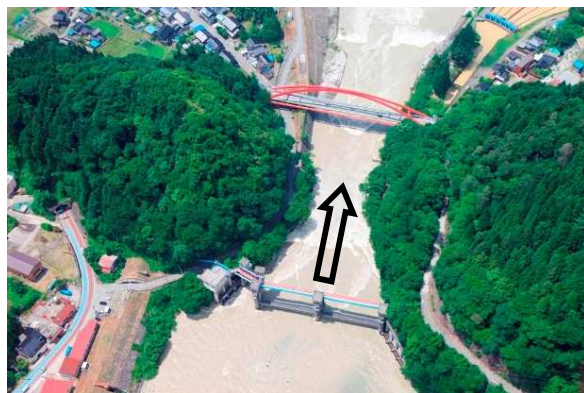
愛本合口堰堤（河口より13.5km）
