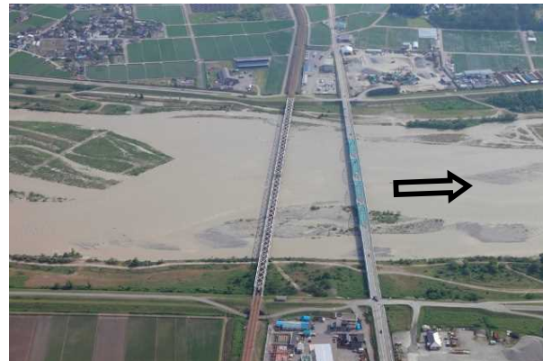
下黒部橋（河口より0.8km）
