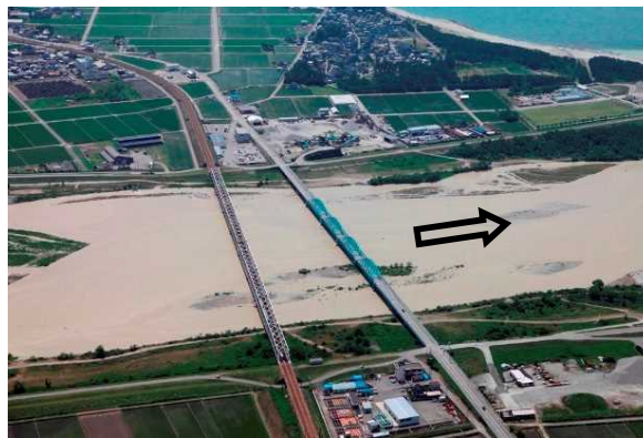
下黒部橋（河口より0.8km）
