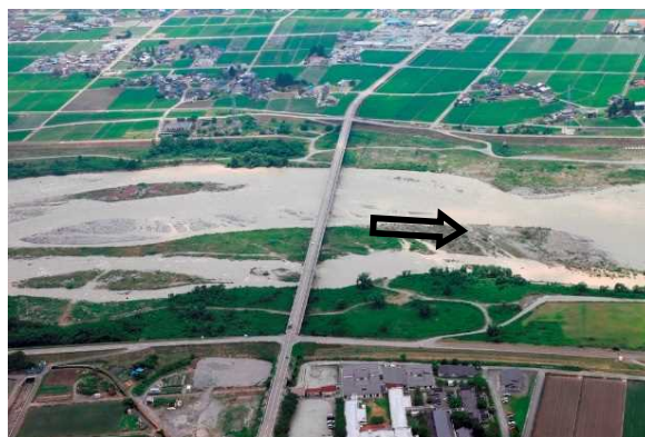
新川黒部橋（河口より9.6km）
