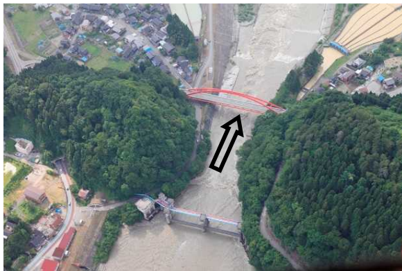
愛本合口堰堤（河口より13.5km）
