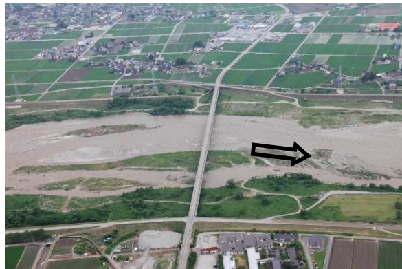
新川黒部橋（河口より9.6km）
