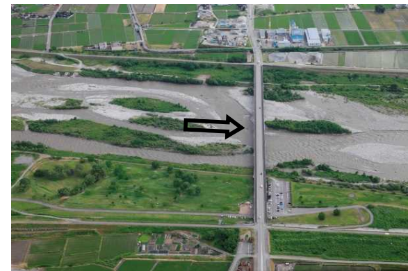
権蔵橋（河口より8.2km）
