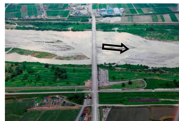
権蔵橋（河口より8.2km）
