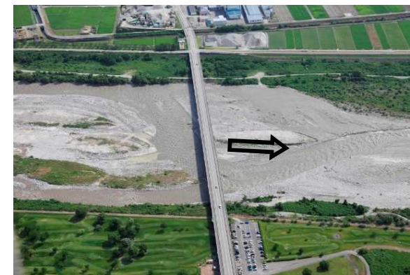
権蔵橋（河口より8.2km）
