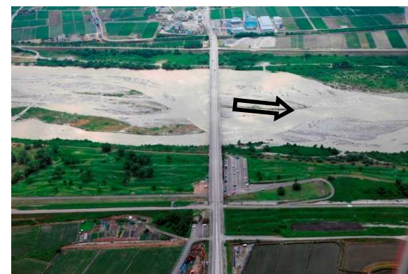
権蔵橋（河口より8.2km）
