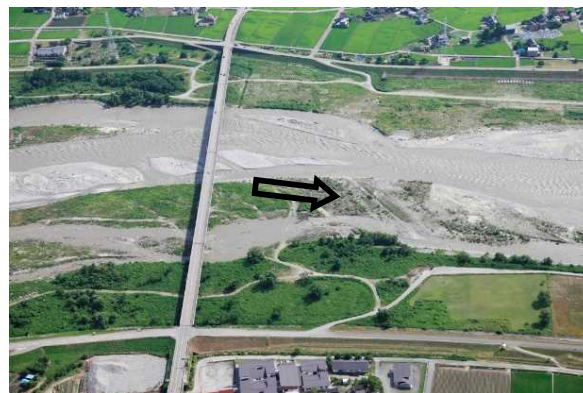
新川黒部橋（河口より9.6km）
