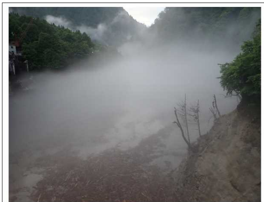
【出し平ダム湛水池】水位低下中(EL.316.00m) 6月27日 5:00撮影
