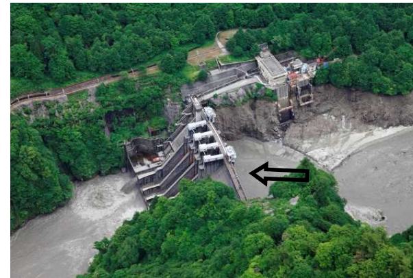
出し平ダム(左岸より望む)
