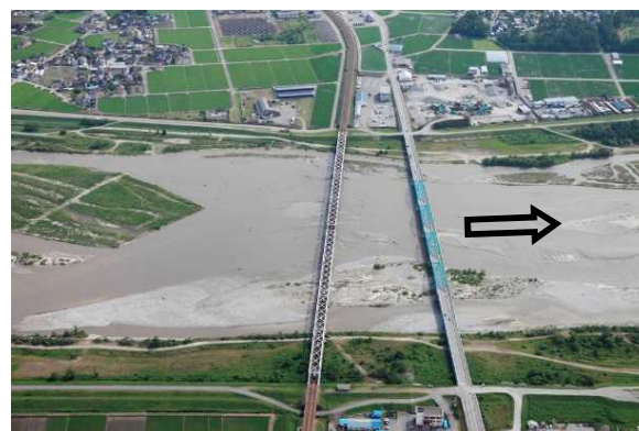
下黒部橋（河口より0.8km）
