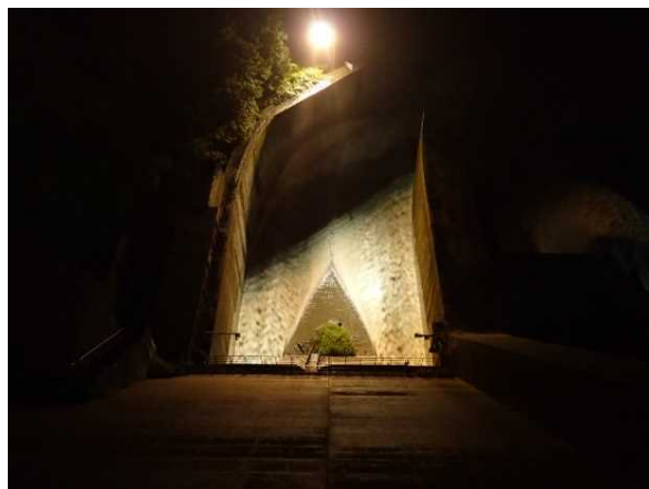
排砂ゲート開操作10分後 【6月26日22時10分】
