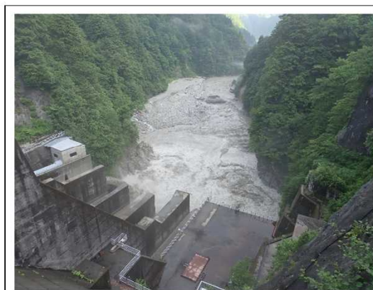
【出し平ダム下流】自然流下開始時(EL.306.72m) 6月27日 6:34撮影
