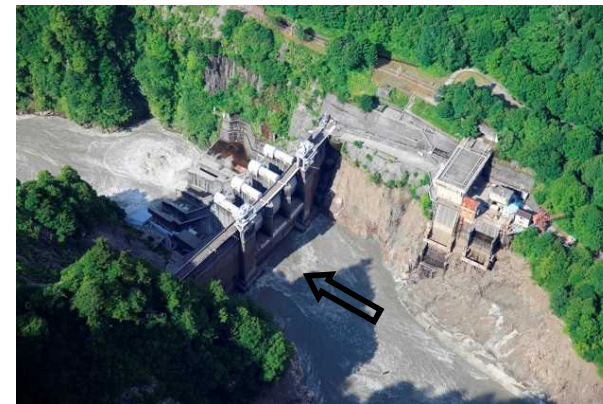
出し平ダム(左岸より望む)
