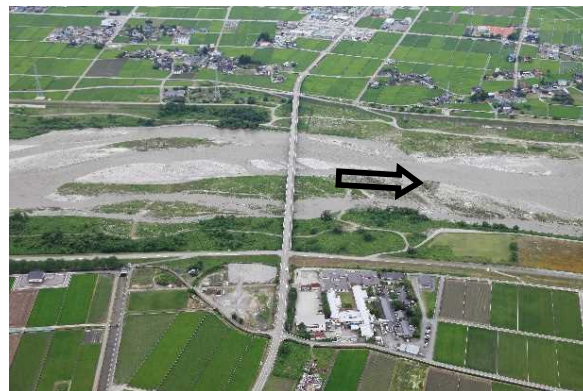
新川黒部橋（河口より9.6km）
