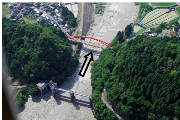
愛本合口堰堤（河口より13.5km）
