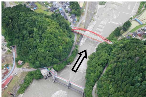
愛本合口堰堤（河口より13.5km）
