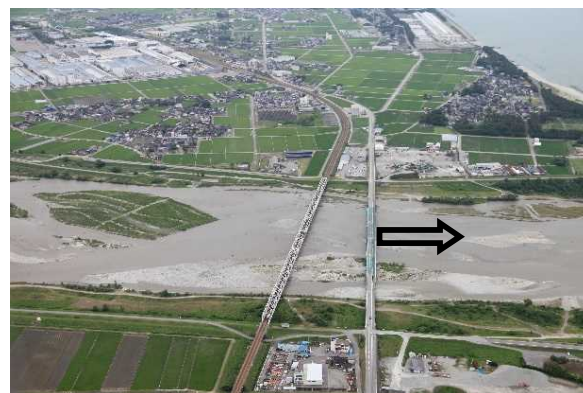
下黒部橋（河口より0.8km）
