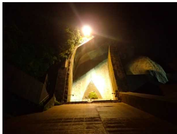
排砂ゲート開操作20分後 【6月26日22時20分】
