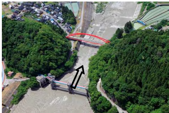
愛本合口堰堤（河口より13.5km）
