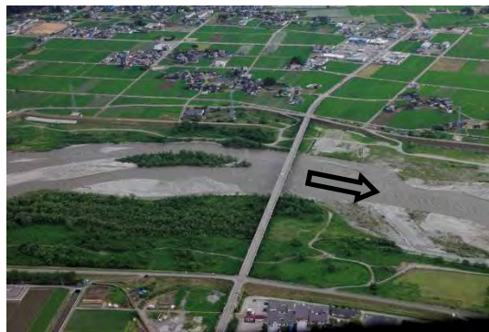
新川黒部橋（河口より9.6km）
