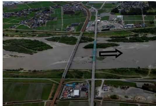
下黒部橋（河口より0.8km）
