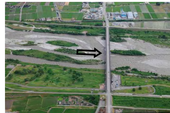
権蔵橋（河口より8.2km）
