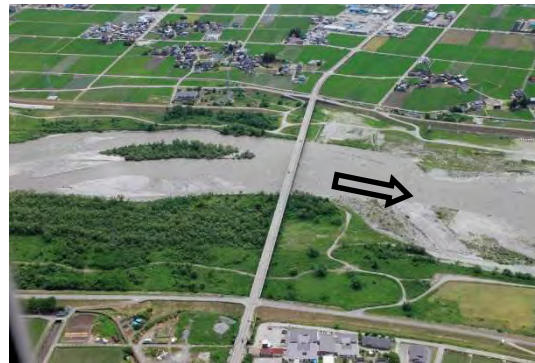
新川黒部橋（河口より9.6km）
