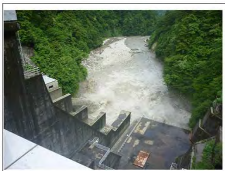
【出し平ダム下流】水位低下中(EL.316.10m) 6月17日 9:20撮影
