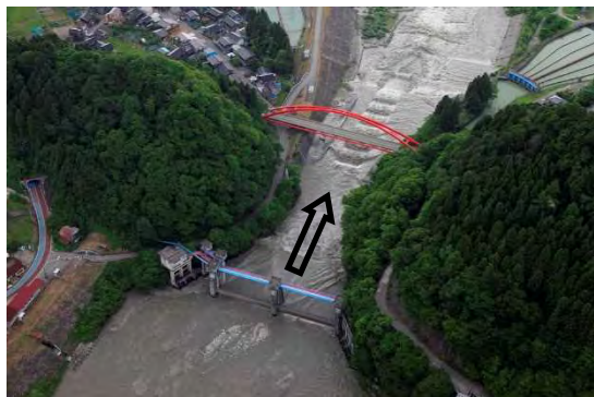
愛本合口堰堤（河口より13.5km）
