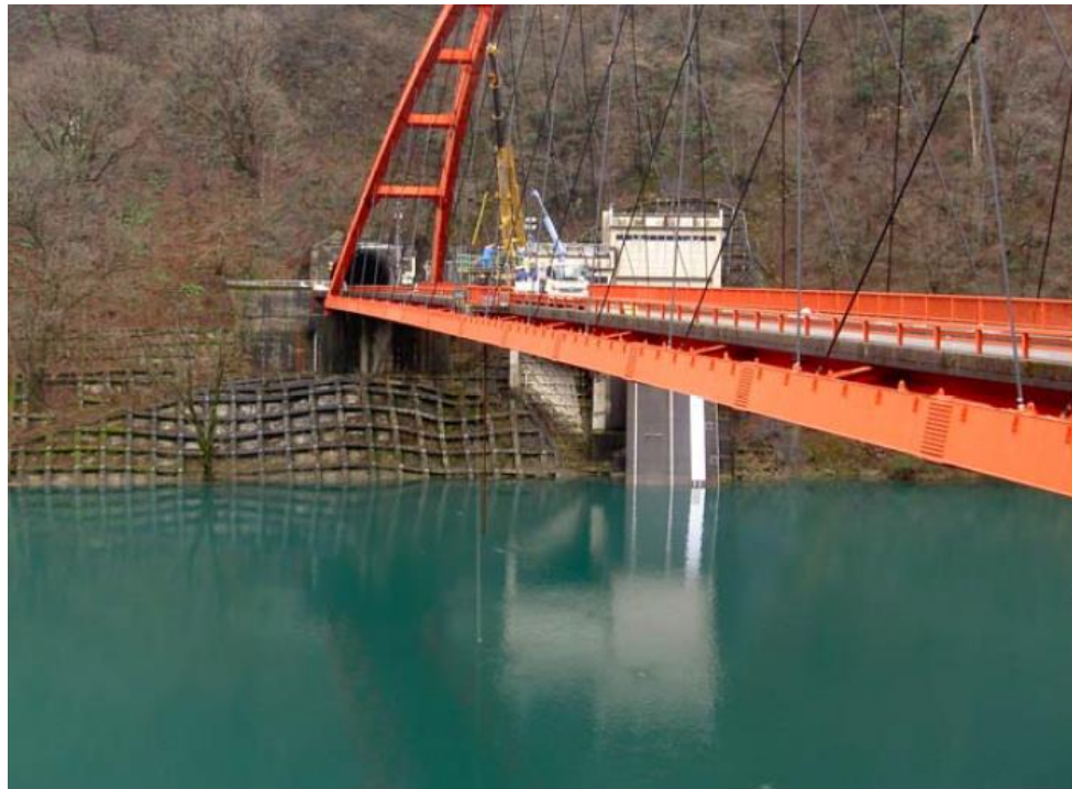
写真-1 全景 湖面橋中央付近での作業を実施
