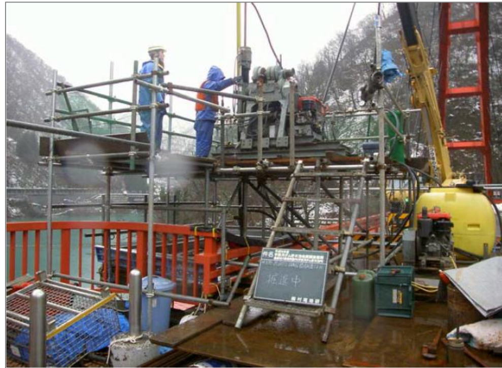
写真-2 ボーリング作業状況 湖面橋手摺りより外側へ足場等を張り出して作業を実施。
