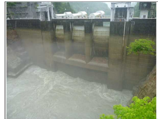
【出し平ダム排砂路呑み口部】自然流下完了(EL.308.80m) 7月7日 8:50撮影
