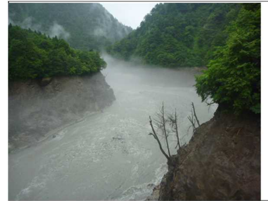
【出し平ダム湛水池】自然流下完了(EL.308.80m) 7月7日 8:50撮影
