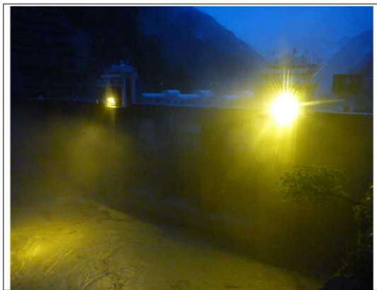
【出し平ダム排砂路呑み口部】水位低下中(EL.315.77m) 7月6日 19:30撮影
