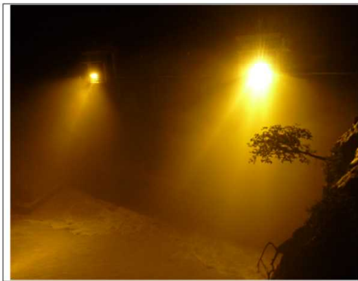
【出し平ダム排砂路呑み口部】自然流下中(EL.309.25m) 7月6日 20:50撮影
