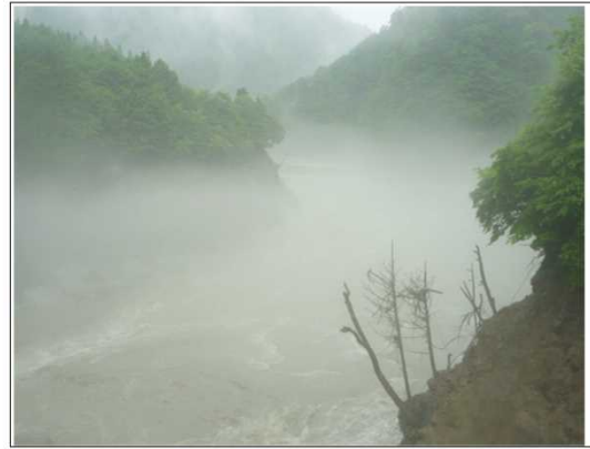
【出し平ダム 湛水池】水位低下中(EL.315.65m) 6月28日 7:00撮影
