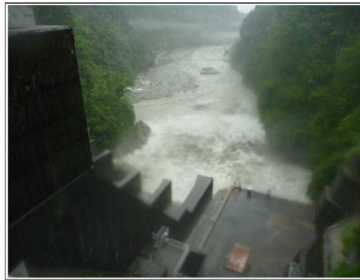
【出し平ダム 下流】自然流下中(EL.308.55m) 6月28日 10:00撮影
