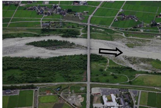
新川黒部橋（河口より9.6km）
