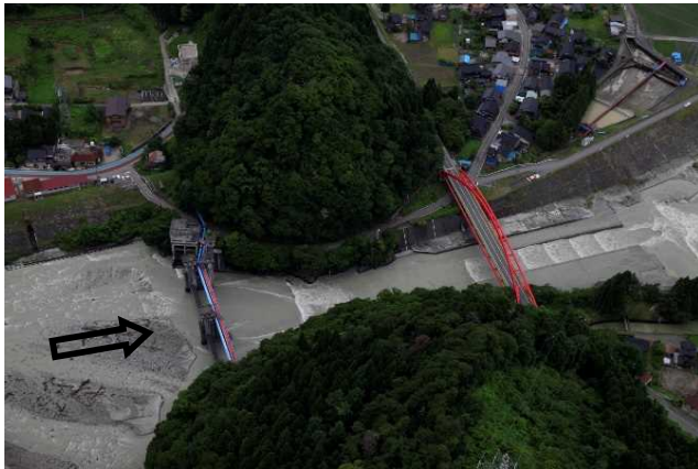
愛本合口堰堤（河口より13.5km）
