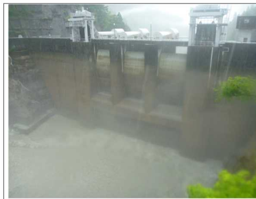
【出し平ダム 排砂路呑み口部】自然流下中(EL.305.88m) 6月28日 10:00撮影
