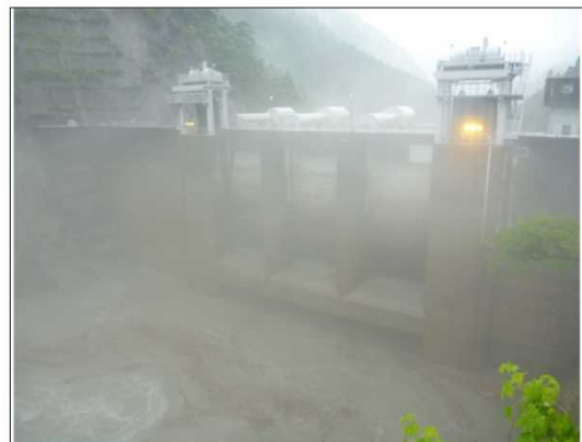
【出し平ダム 排砂路呑み口部】水位低下中(EL.315.65m) 6月28日 7:00撮影
