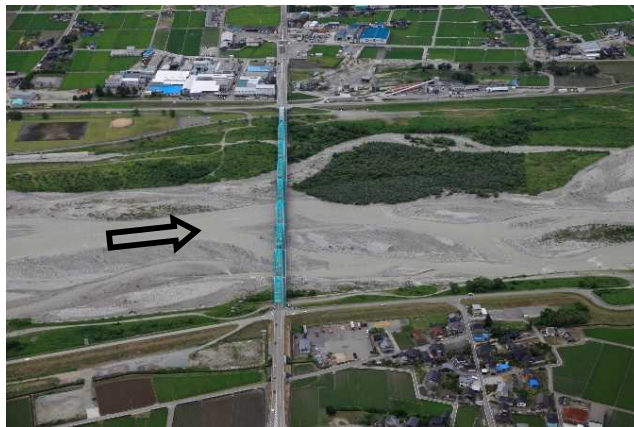
黒部大橋(国道8号)（河口より4.8km）
