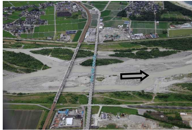
下黒部橋（河口より0.8km）
