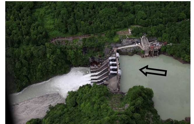
出し平ダム（左岸より望む）
